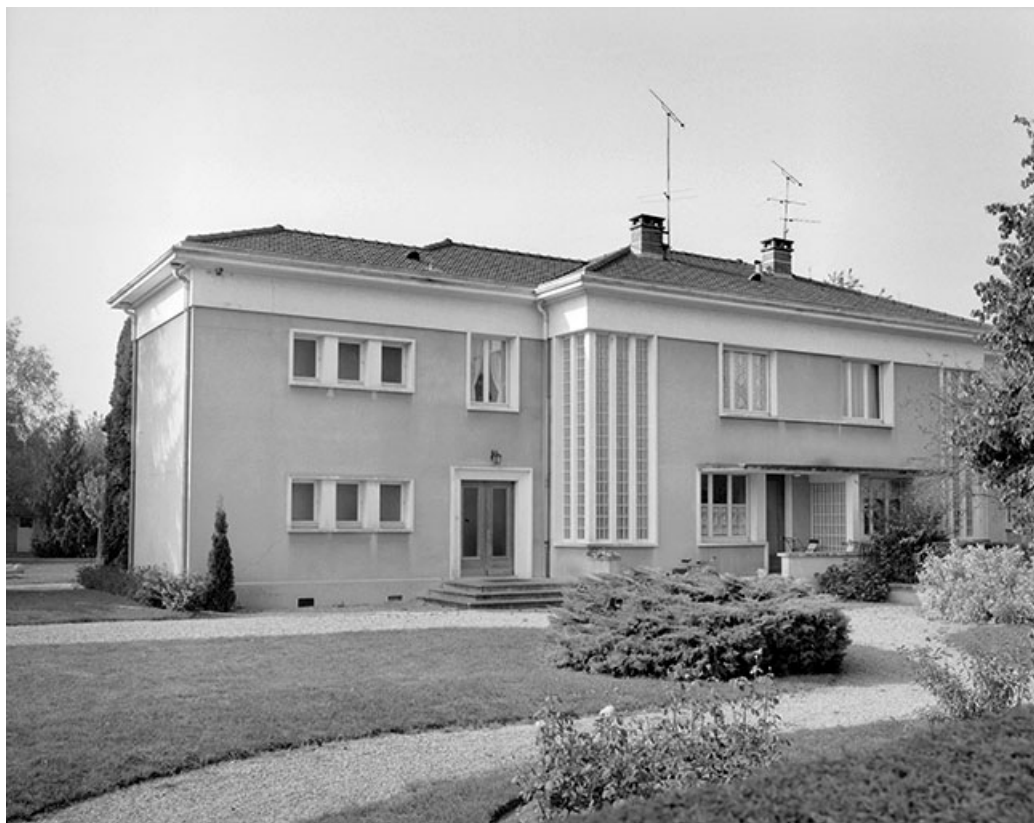
Maison d'ingénieurs de type 5D, 6, 8 rue Marin La Meslée, façade postérieure et face gauche. 39, Tavaux, 10, 12 rue Rouget de Lisle, lieudit : Tavaux Cité
