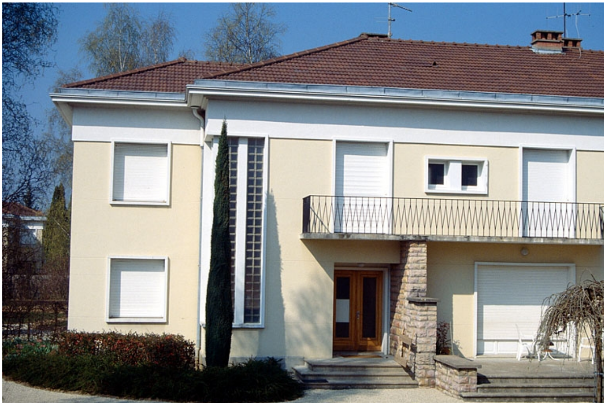
Maison d'ingénieurs de type 5E, 5 rue Rouget de Lisle-22 avenue Albert 1er, façade du 5 rue Rouget de Lisle. 39, Tavaux, 10, 12 rue Rouget de Lisle, lieudit : Tavaux Cité
