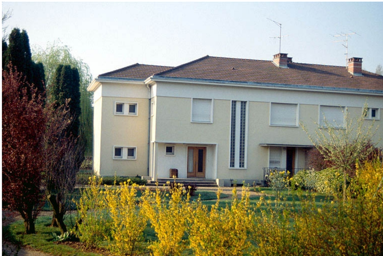
Maison d'ingénieurs de type 5E, 5 rue Rouget de Lisle-22 avenue Albert 1er, façade du 22 avenue Albert 1er. 39, Tavaux, 10, 12 rue Rouget de Lisle, lieudit : Tavaux Cité
