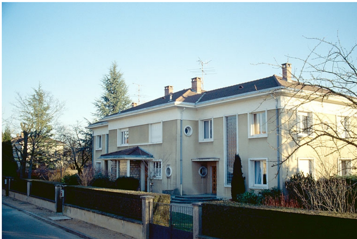
Maison d'ingénieurs de type 5B, 10, 12 rue Marin La Meslée.
