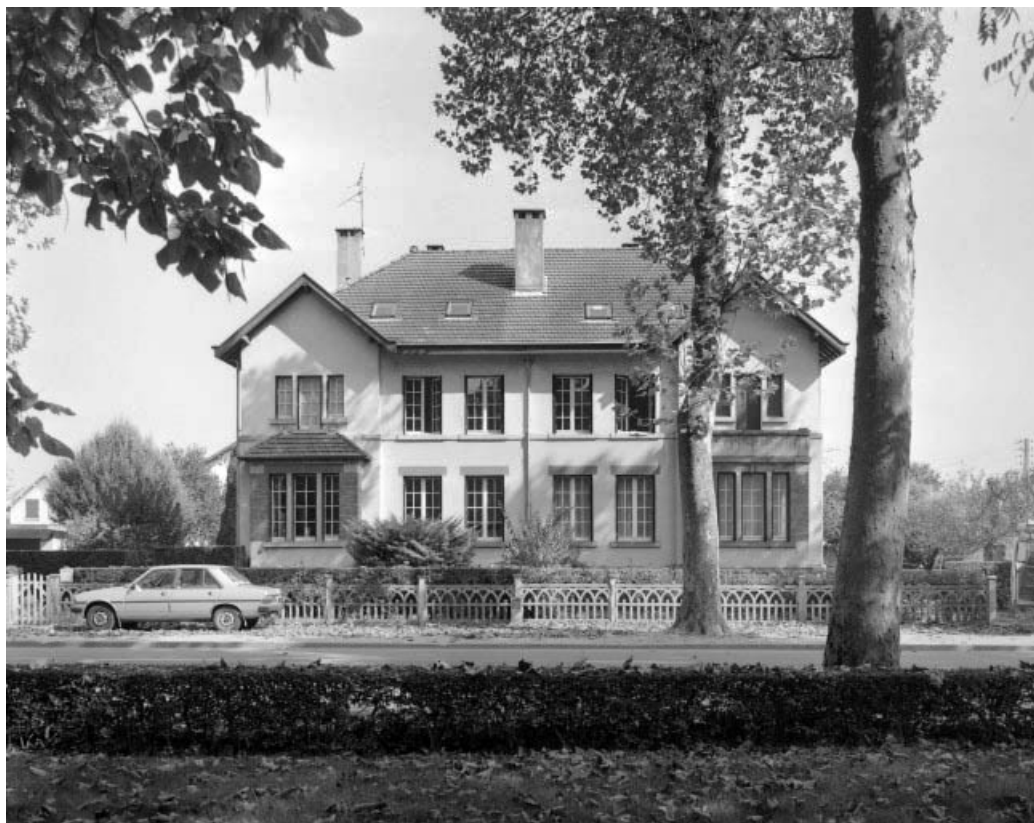
Façade antérieure de la maison voisine, 41-43 avenue de la République, vue de face.
