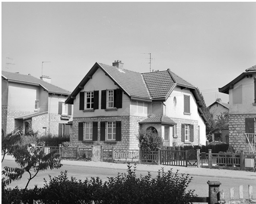
Maison de même type, 22, 24 rue de Rome, façade antérieure et face droite.
