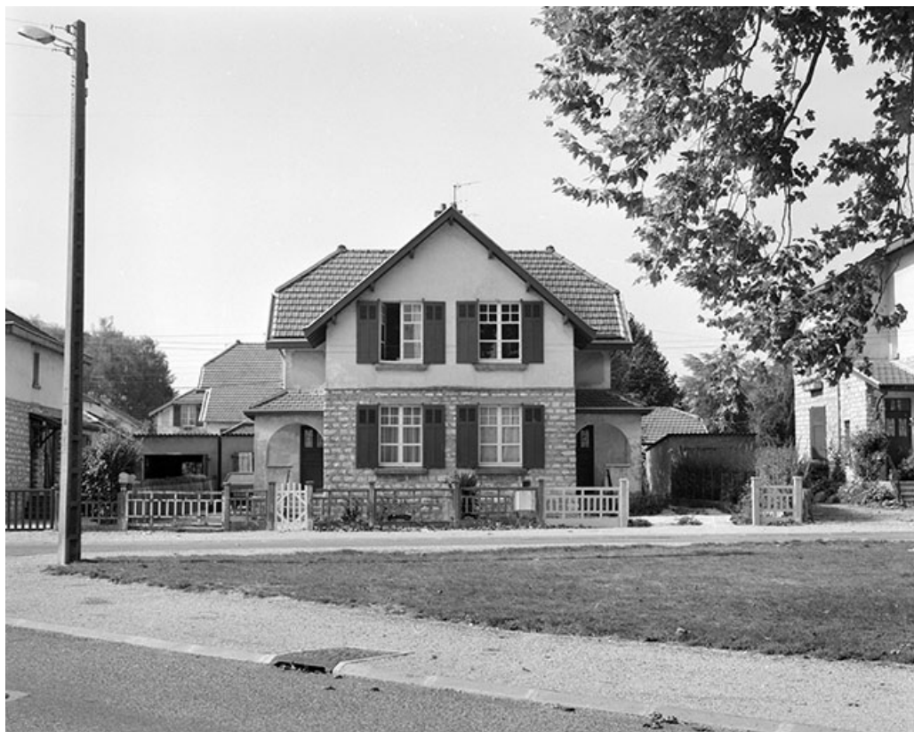
Maison de même type, 22, 24 rue de Rome, façade antérieure.
