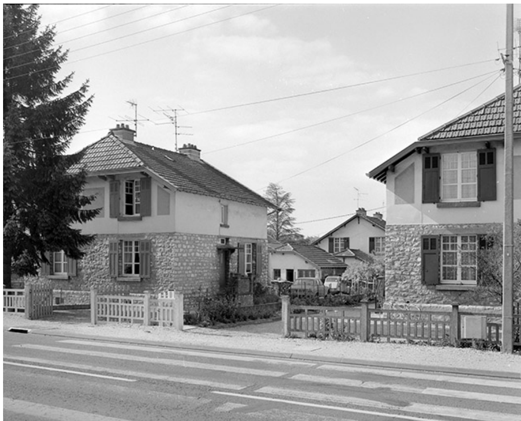
Maison identique, 40, 42 rue de Belvoje, façade antérieure et face droite.
