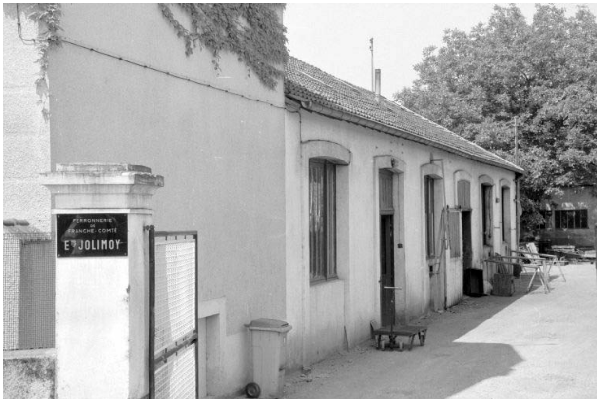
Bâtiment de l'atelier de fabrication, du magasin industriel et du bureau. 39, Dole, 61, 63 rue de Crissey
