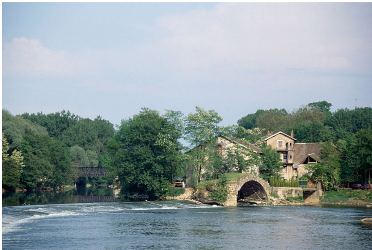
Vue d'ensemble, depuis l'ouest.
