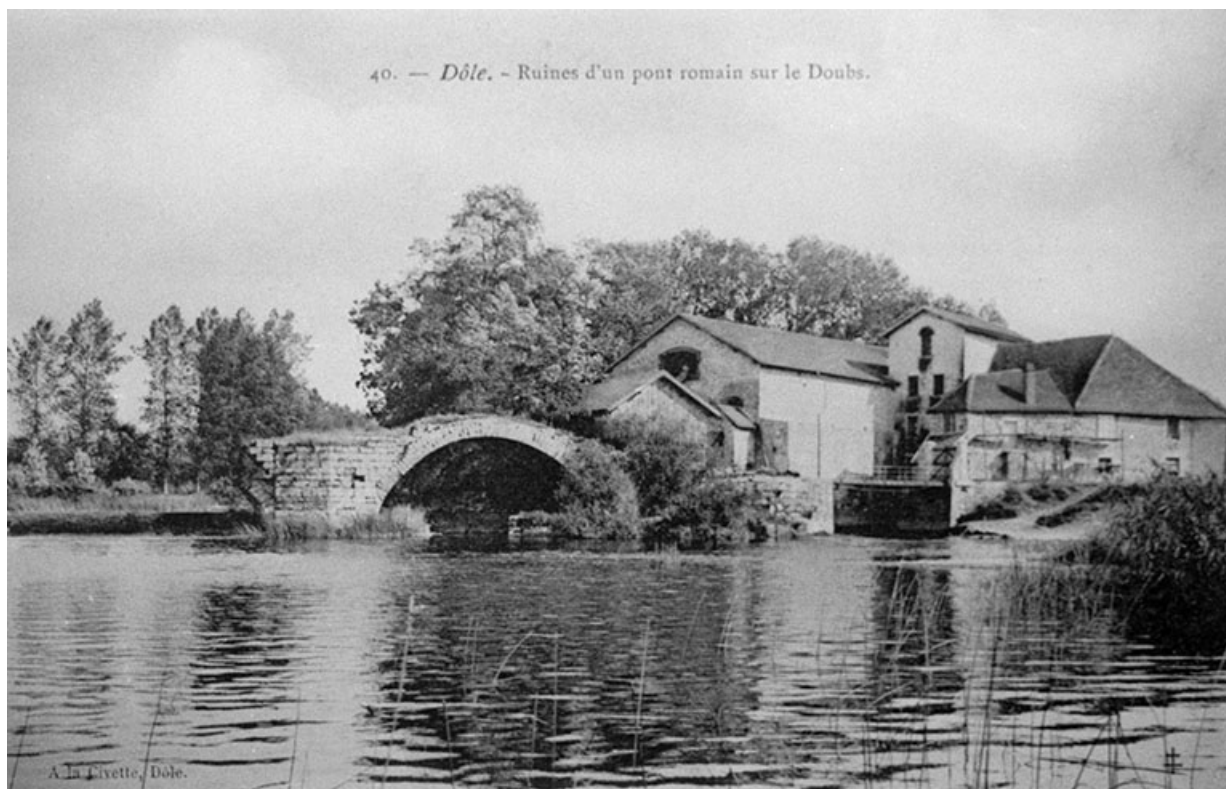
Dôle. - Ruines d'un pont romain sur le Doubs.
