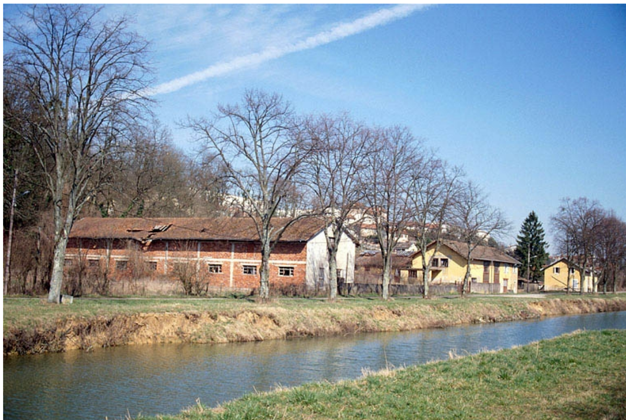
Etable, atelier de fabrication et bureau, depuis le sud.
