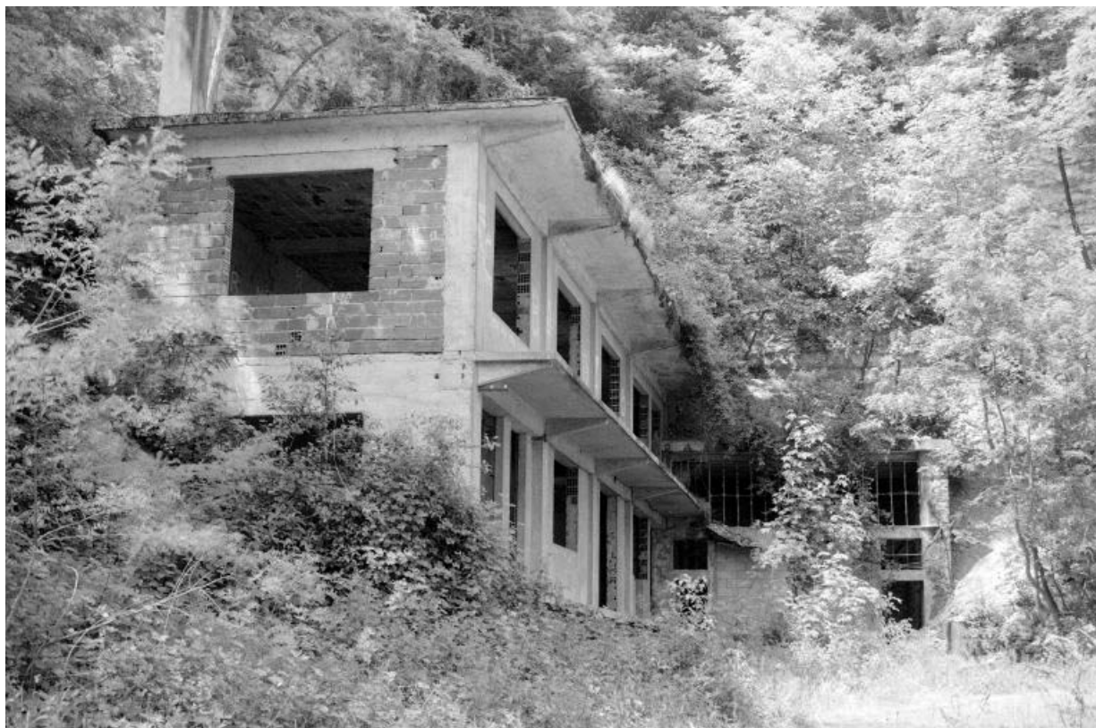
Logements d'ouvriers inachevés et entrée de la carrière souterraine.
