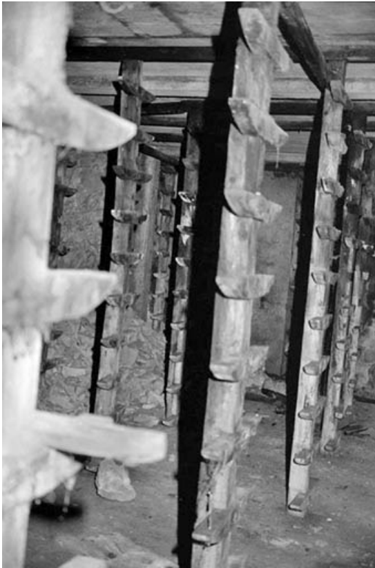
Intérieur de la carrière souterraine : supports d'étagères à fromages d'une pièce d'affinage. 39, Dole, 50 à 58, 72 chemin des Rivières
