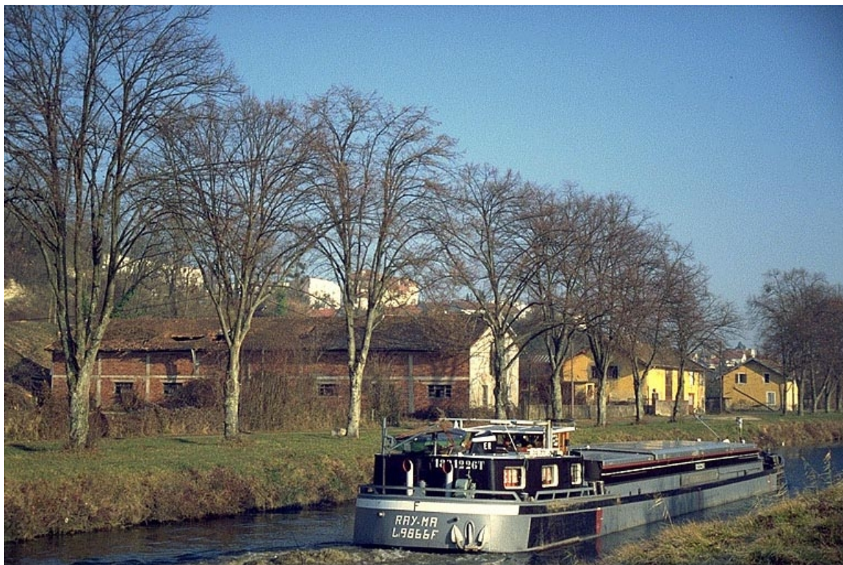
Etable, atelier de fabrication et bureau depuis le sud, avec péniche au premier plan.
