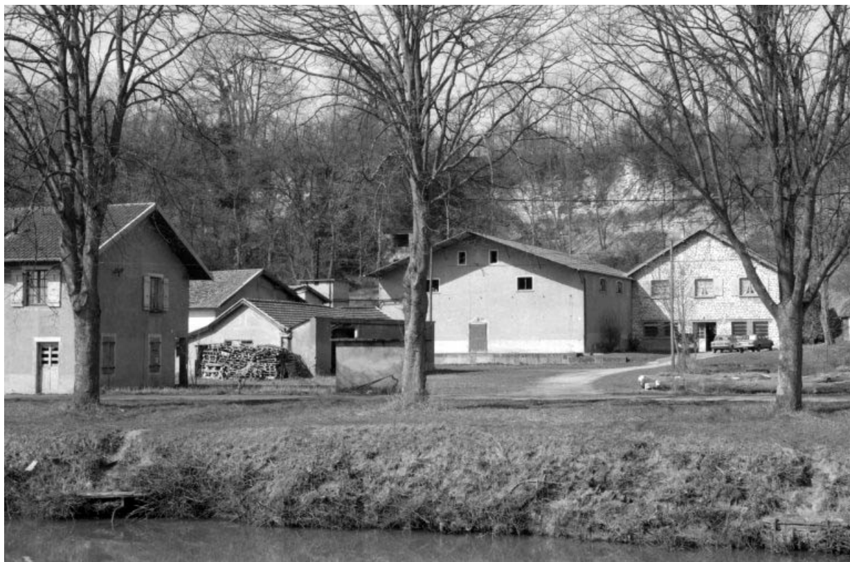
Chaufferie, chambre froide (pièce d'affinage), salle des machines et logement d'ouvriers.
