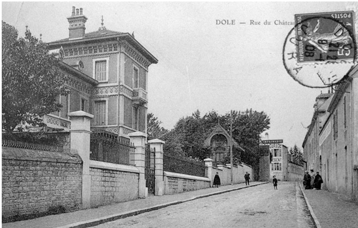
Dole - Rue du Château d'eau. 39, Dole, 80, 82 rue Mont Roland
