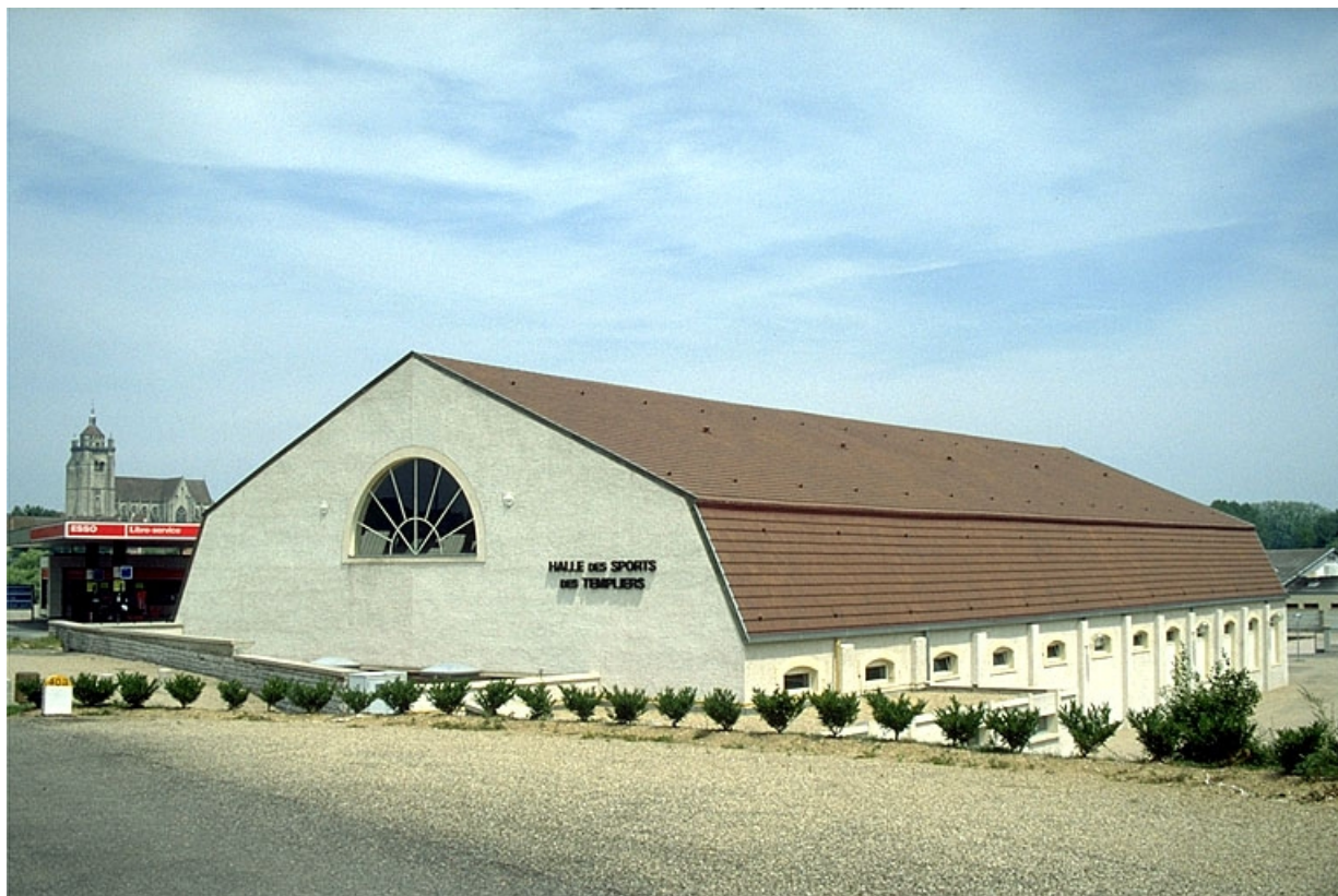
Vue d'ensemble du gymnase, depuis le sud-ouest.
