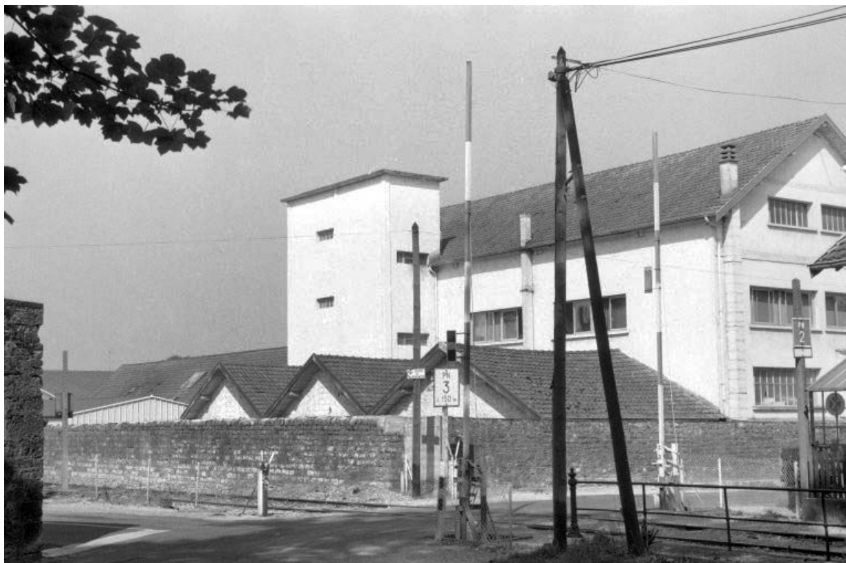
Façade postérieure des ateliers (G, H, I), depuis l'est.
