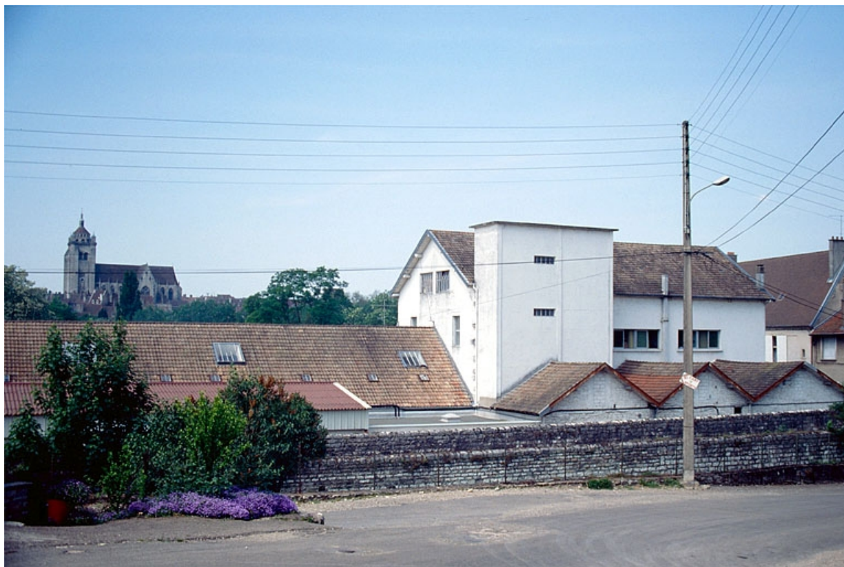
Façade postérieure des ateliers (G, H, I), depuis l'ouest.
