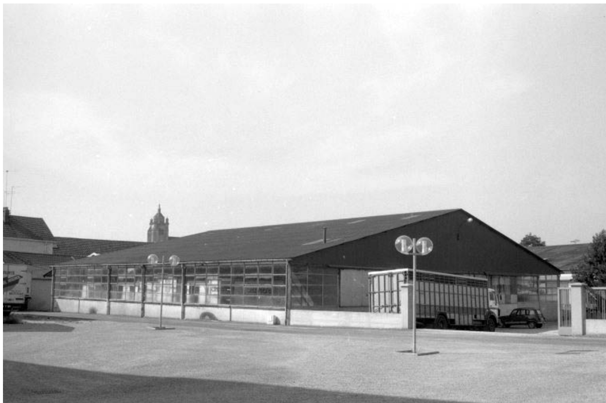
Remise (ancienne usine U.M.D.).
