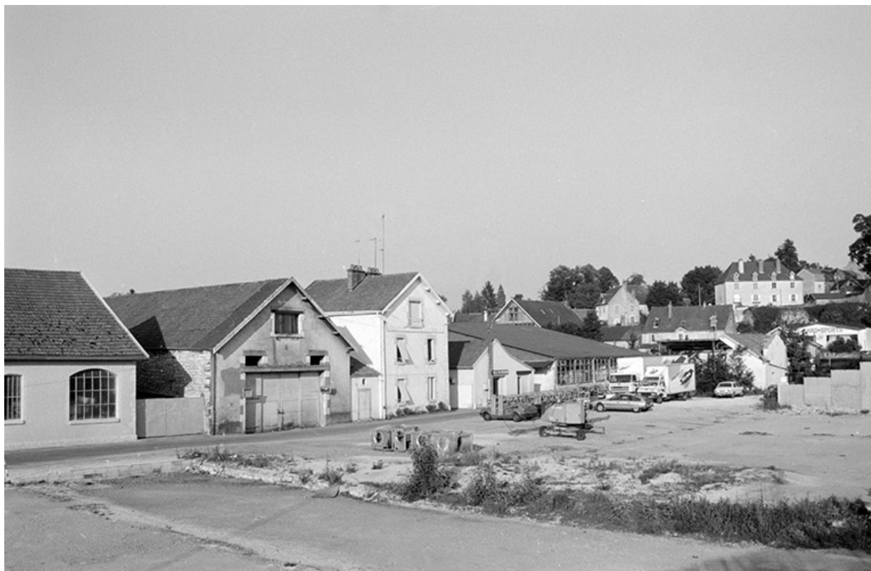
Ancien atelier des Tanneries Réunies (O) et remise (P).
