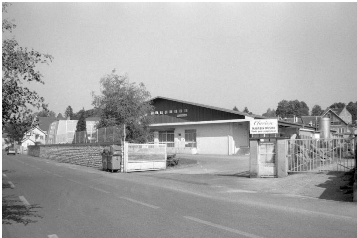
Entrée ouest de l'usine : atelier de fabrication et boutique (O).
