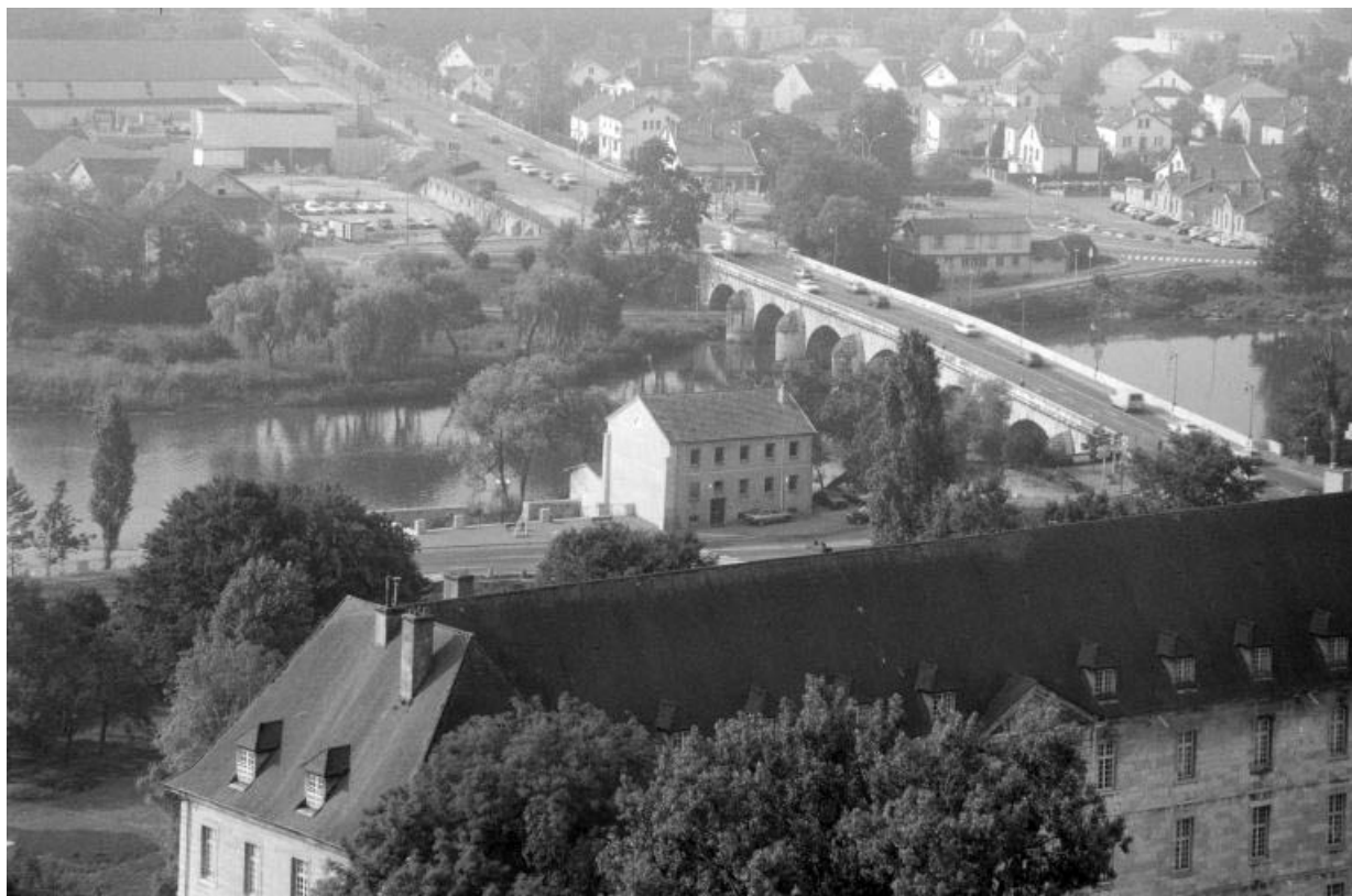
Vue d'ensemble, depuis le haut de la collégiale.
