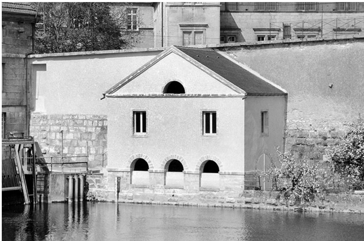
Logement du fontainier en 1990.
