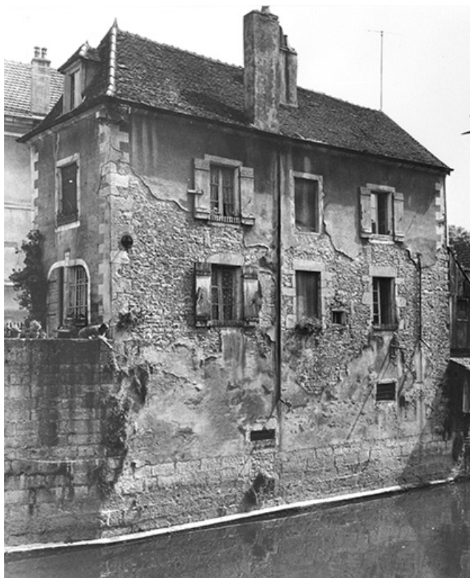
Façade postérieure de la maison datée 1780.
