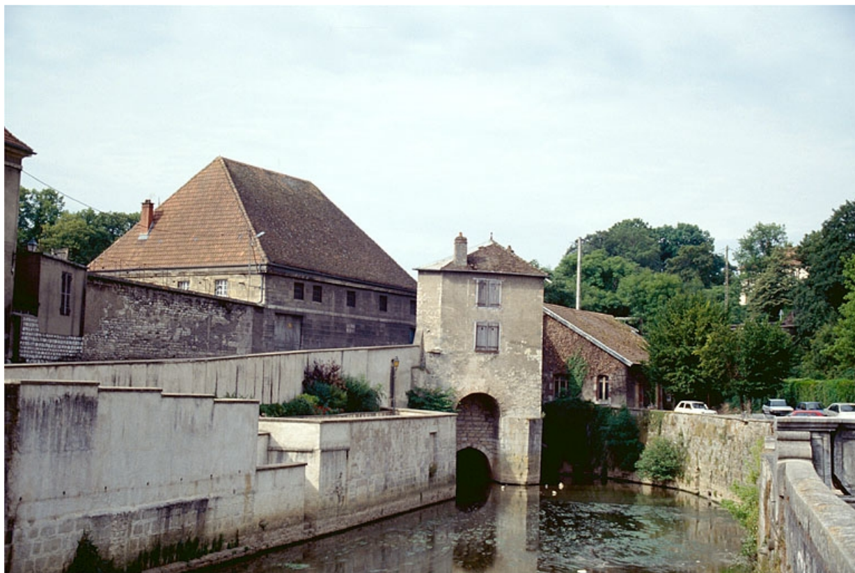
Bureau (ancienne tour de fortification).
