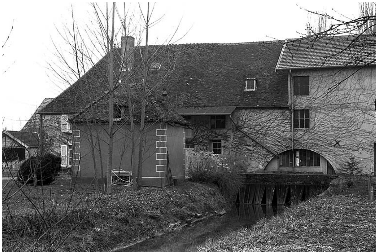
Bureau et minoterie, depuis le nord-est.
