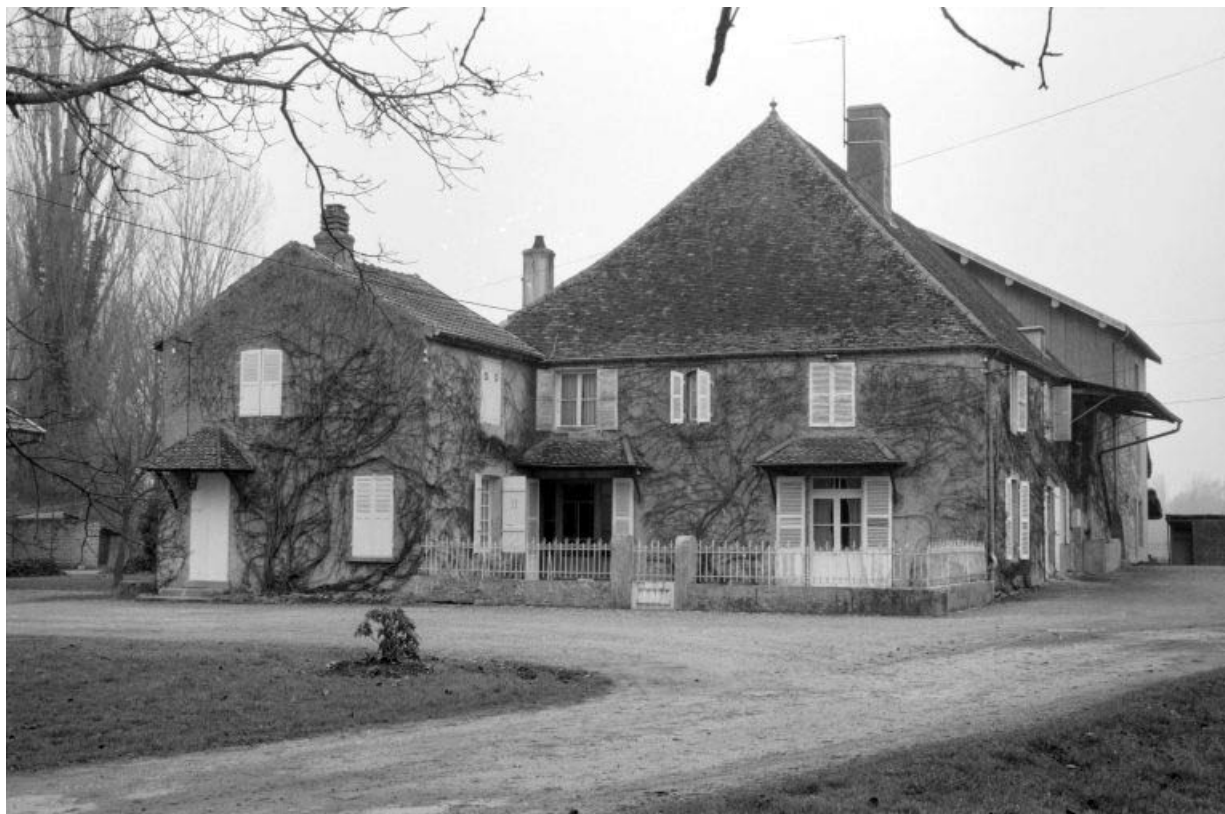
Logement (E) et façade latérale gauche de la minoterie (A).
