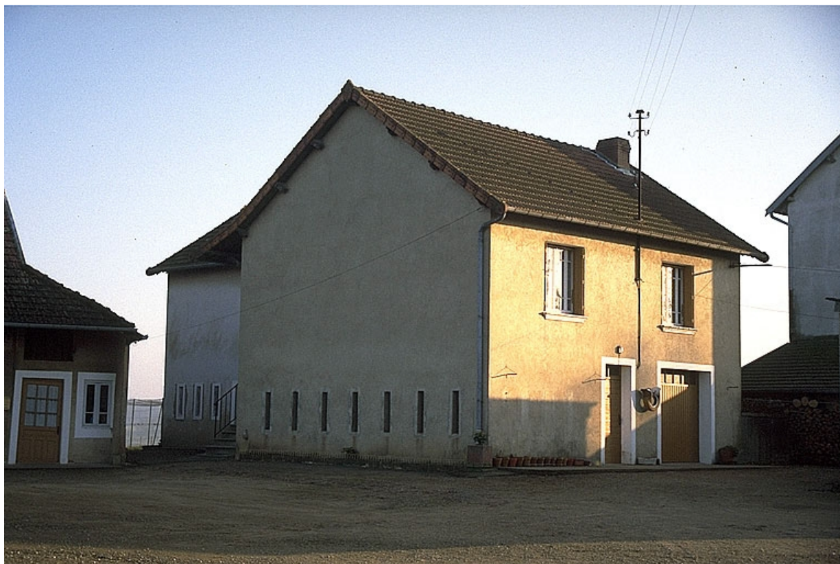
Fromagerie vue du nord.
