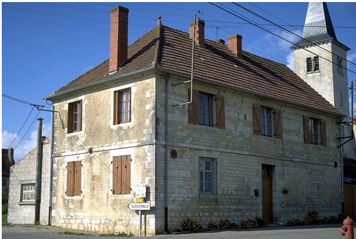
Ancienne école, vue de trois quarts gauche.
