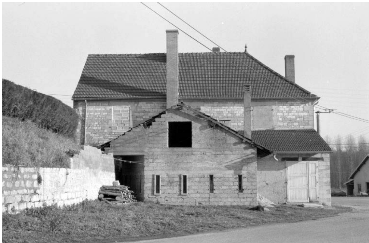
Chambre à lait, depuis l'ouest.
