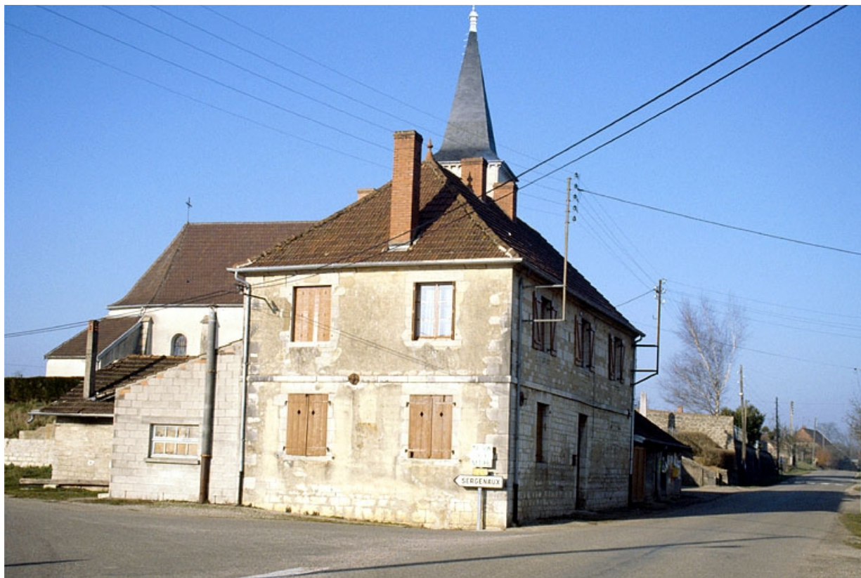
Vue d'ensemble, depuis le sud.
