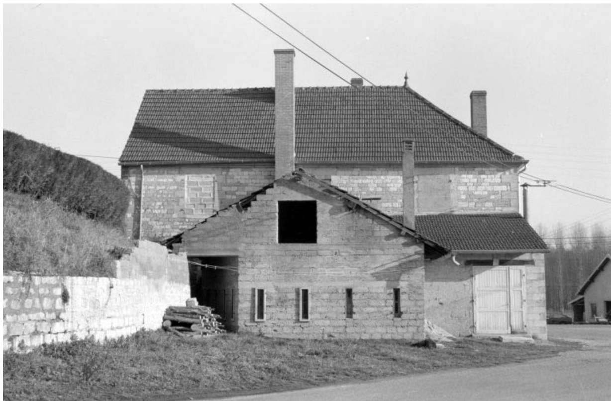
Chambre à lait, depuis l'ouest.
