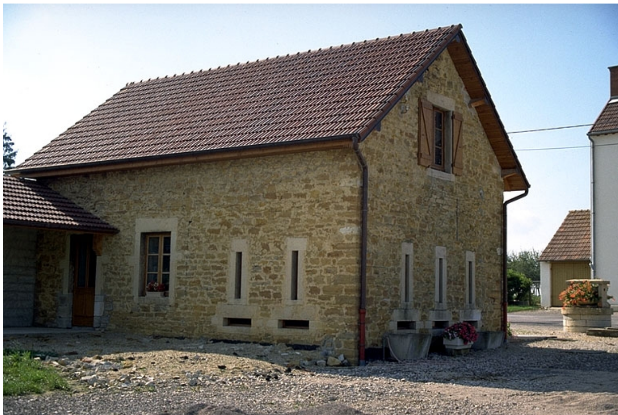
Façades postérieure et latérale gauche. 39, Rye
