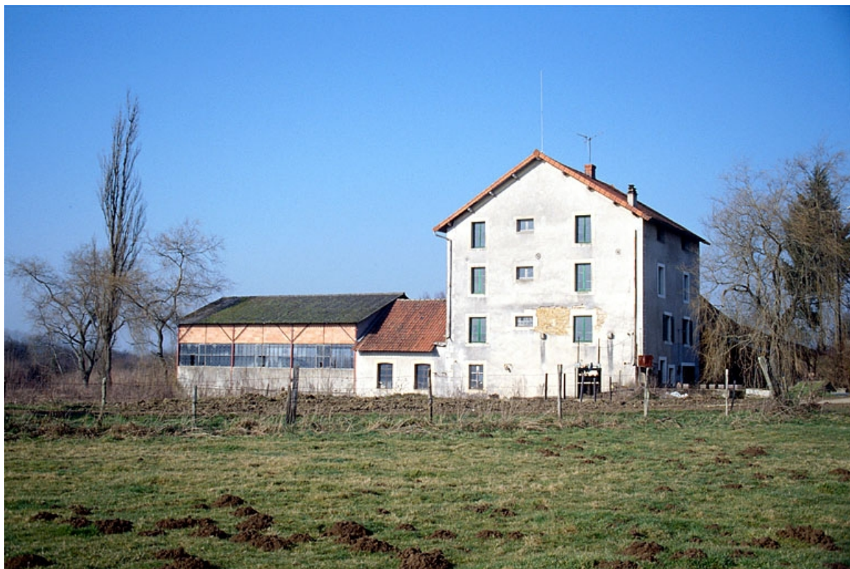
Minoterie, salle des machines et hangar, vus du sud-est.
