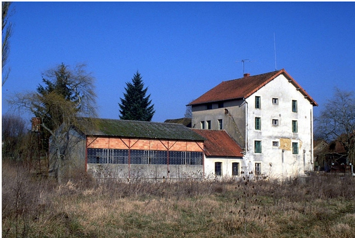
Minoterie, salle des machines et hangar, vus du sud-ouest.
