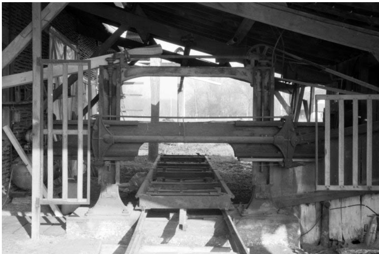
Scie "manchette" : châssis horizontal à lame unique. Le châssis est actionné par la bielle oblique à droite. 39, Commenailles, lieudit : l'Argillois
