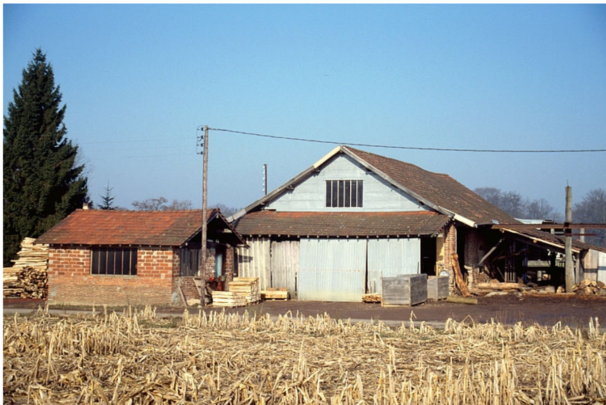
Bureau et atelier de fabrication, vus du sud.
