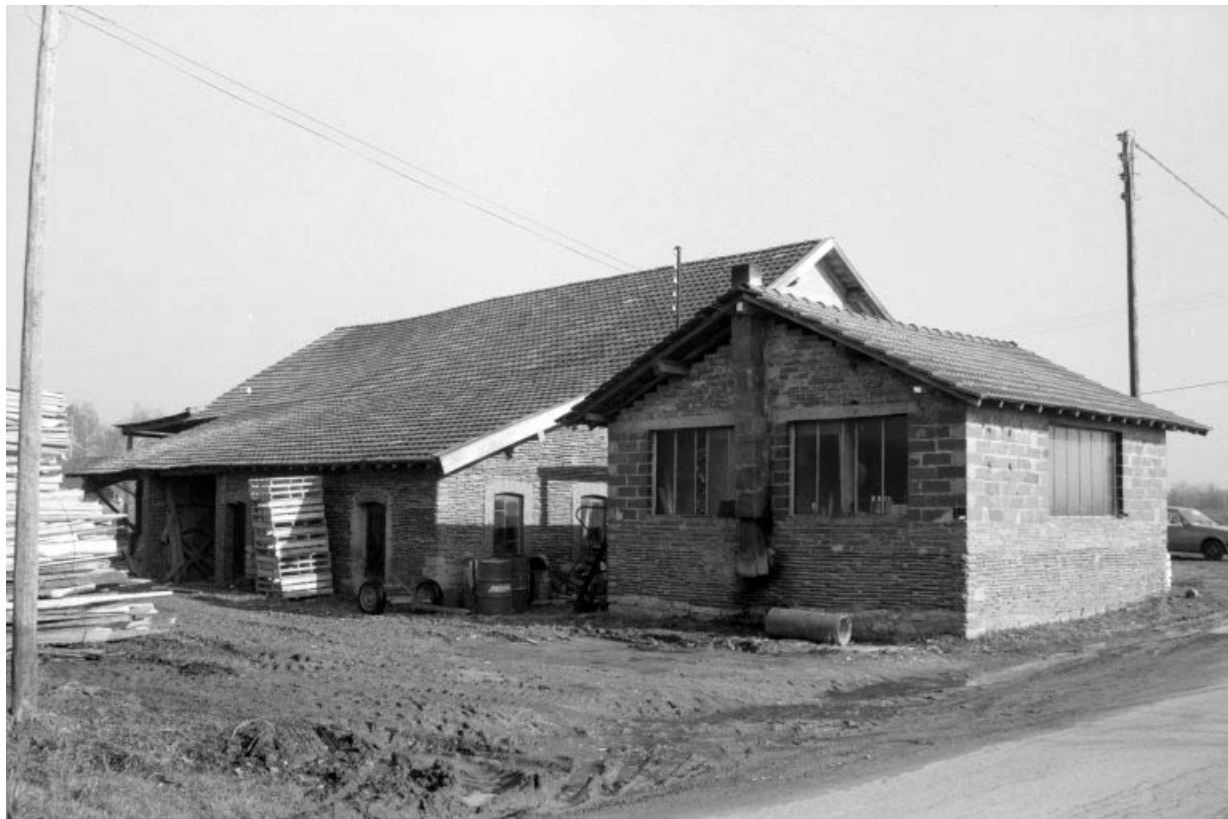
Bureau et atelier de fabrication, vus de l'ouest.
