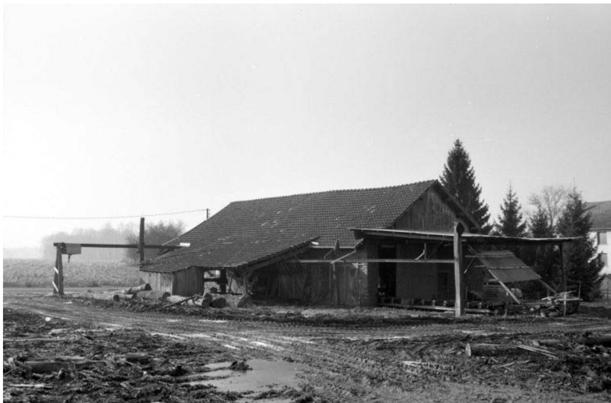
Atelier de fabrication, vu du nord-ouest.
