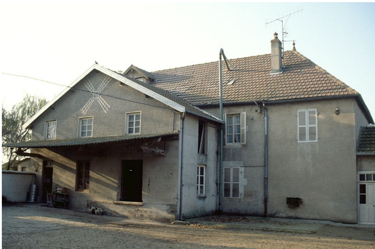
Atelier de fabrication et logement patronal, depuis le nord.
