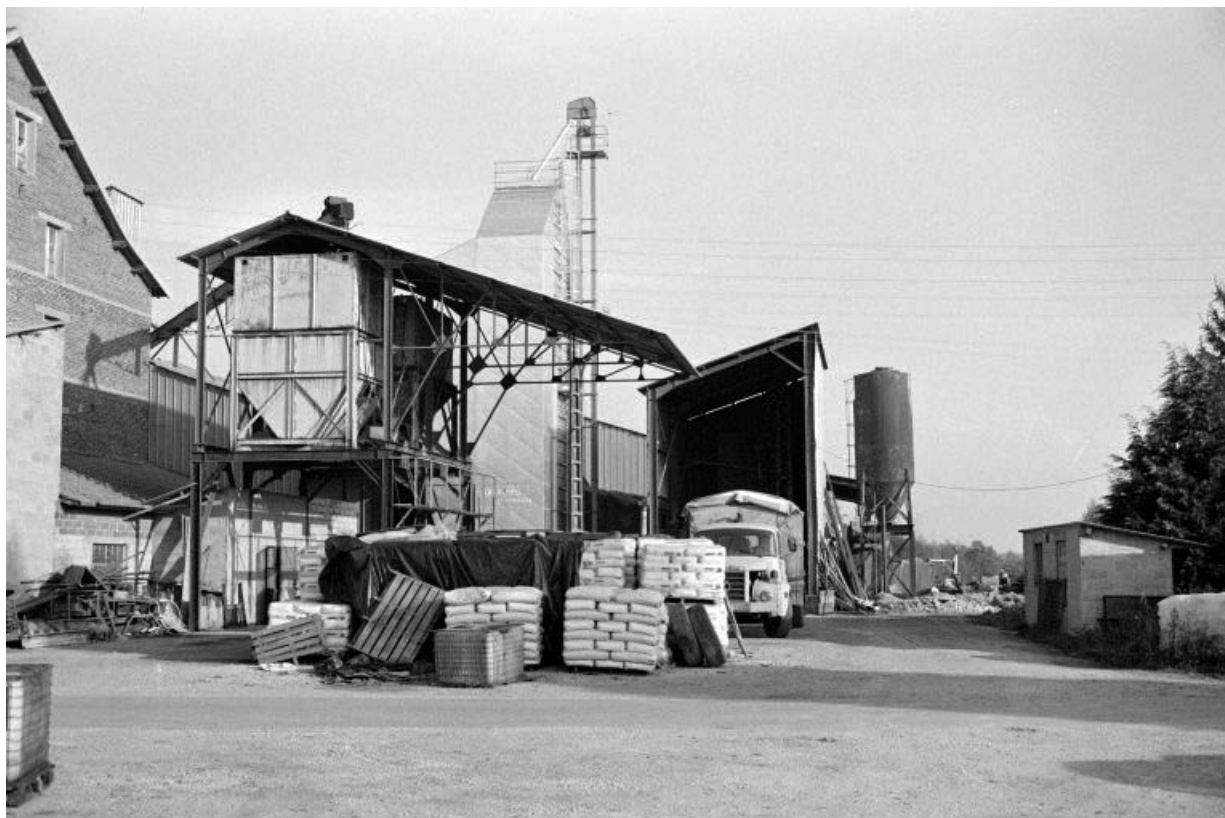
Poste de chargement, séchoir à grains et pont-bascule. 39, Les Hays
