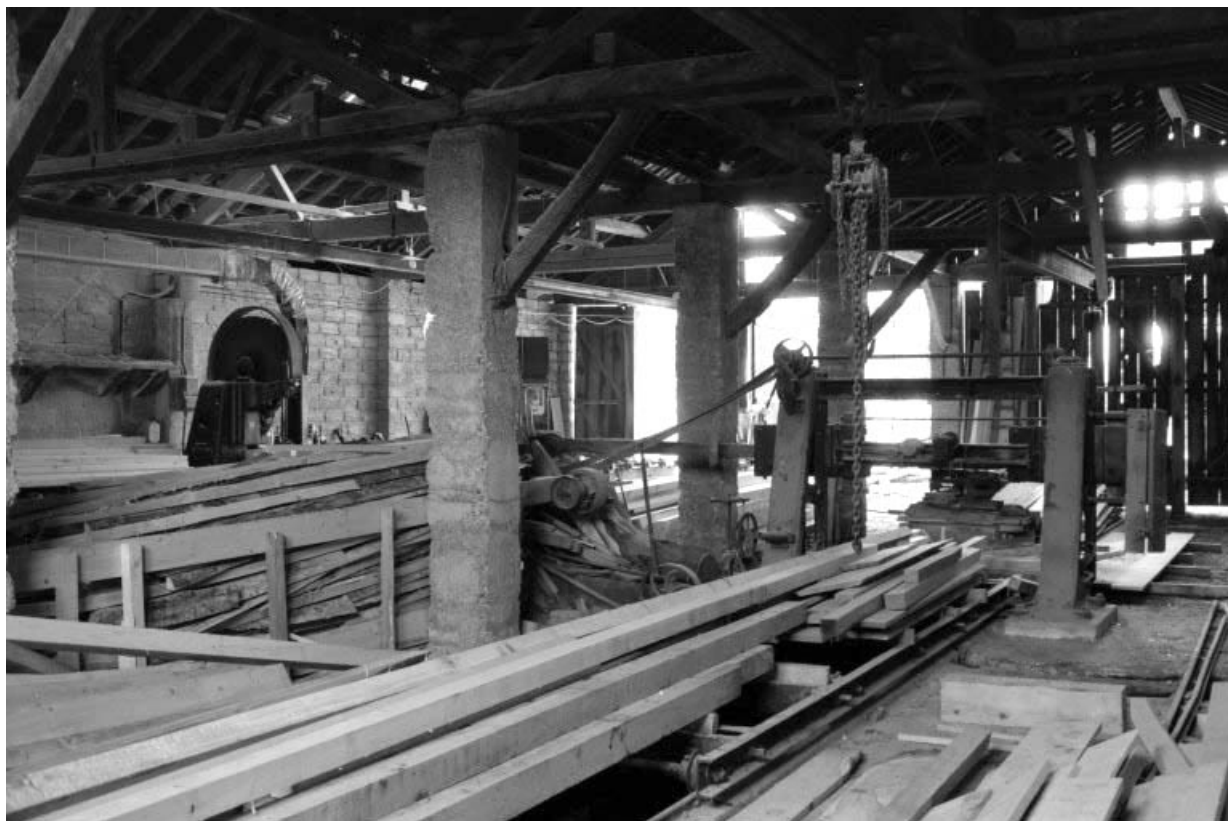
Intérieur de l'atelier de fabrication, depuis l'angle sud-est. 39, Pleure
