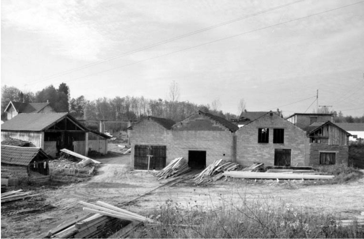
Remise et atelier de fabrication, depuis le sud-est. 39, Pleure
