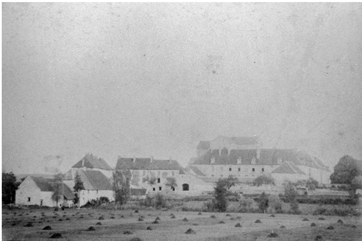
Vue d'ensemble de l'abbaye depuis l'ouest.
