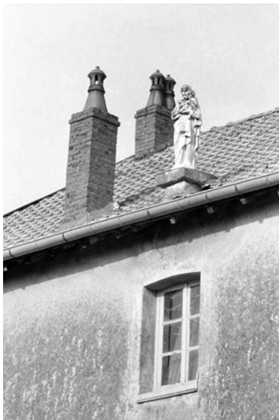
Façade antérieure : baie et statue de saint Joseph.
