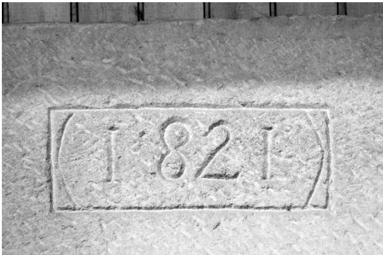
Moulin, porte d'entrée orientale : date portée.
