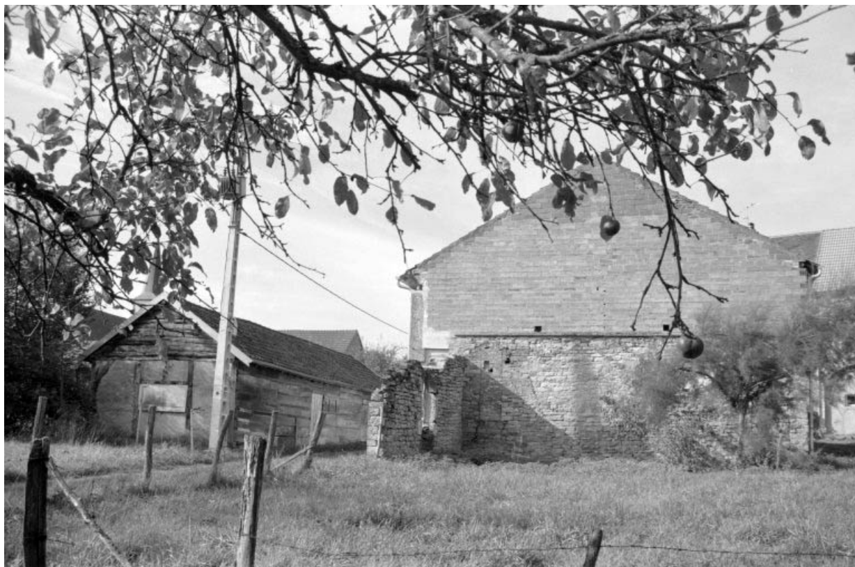
Séchoir (E), bâtiment des fours (C) et emplacement de l'atelier de fabrication.
