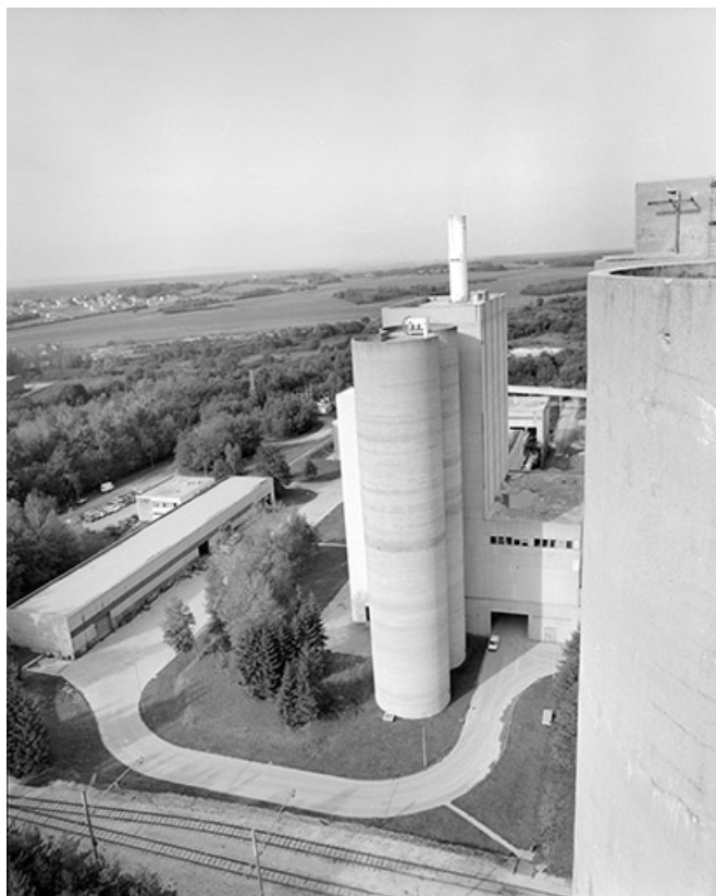
Atelier de fabrication et atelier de réparation (K), depuis le haut des silos. 39, Rochefort-sur-Nenon chemin de la Cimenterie, lieudit : les Etrapeux Nord
