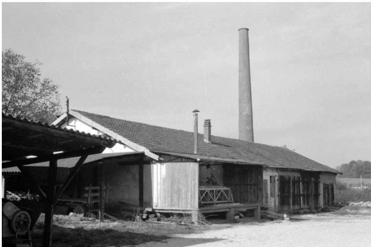
Hangar (C), remise (B) et cheminée d'usine.
