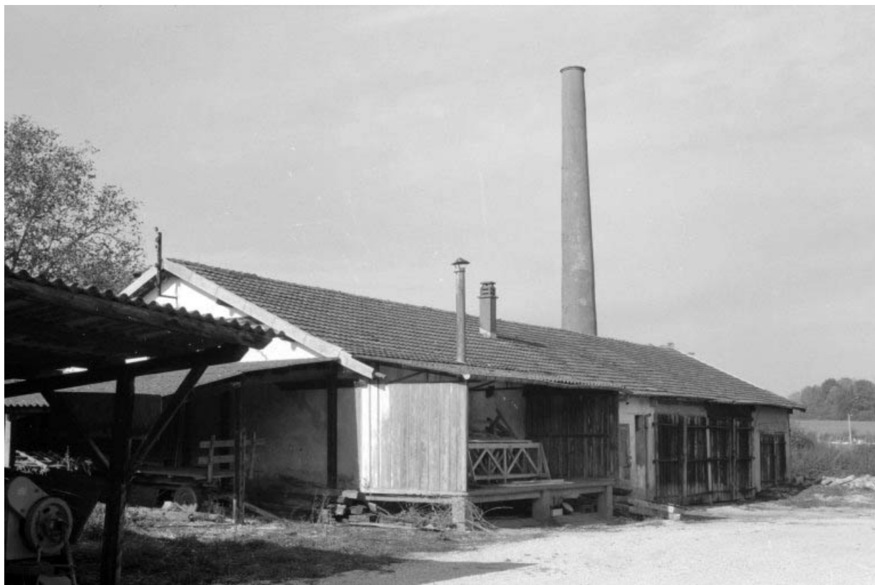
Hangar (C), remise (B) et cheminée d'usine.
