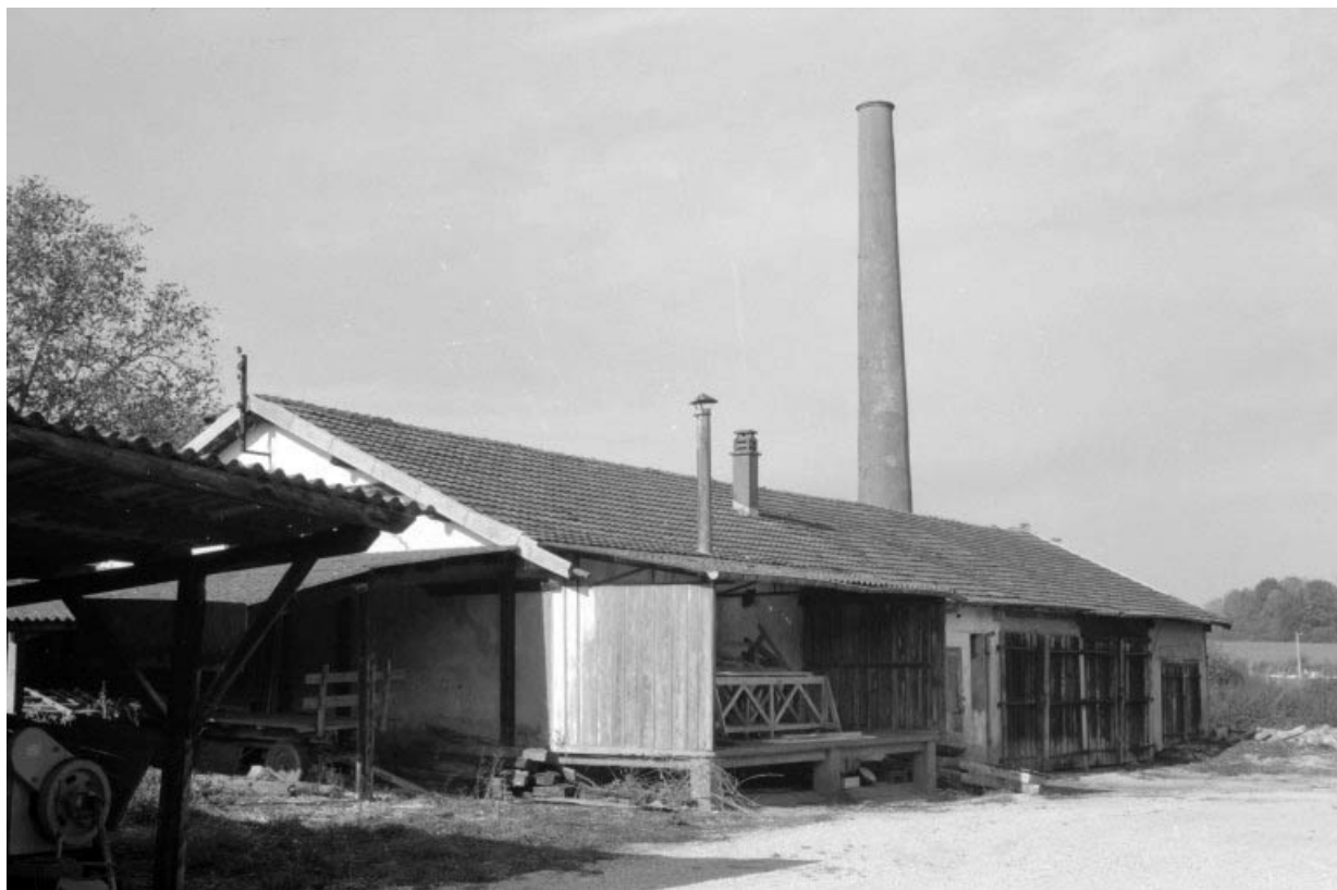
Hangar (C), remise (B) et cheminée d'usine.
