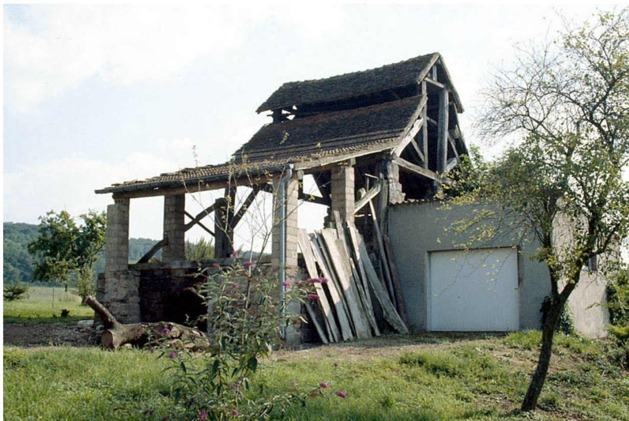
Hangar (abri du four), depuis le nord.
