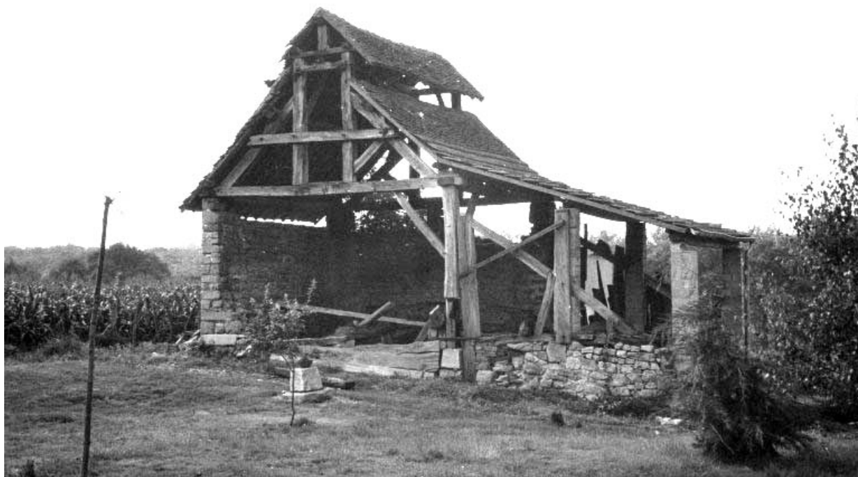
Hangar (abri du four), depuis l'est.
