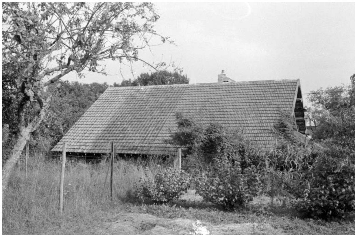
Halle de séchage (C), depuis le nord.
