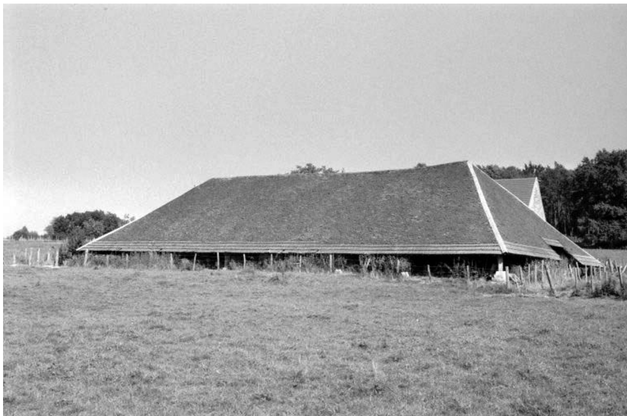
Halle de séchage, depuis l'ouest.
