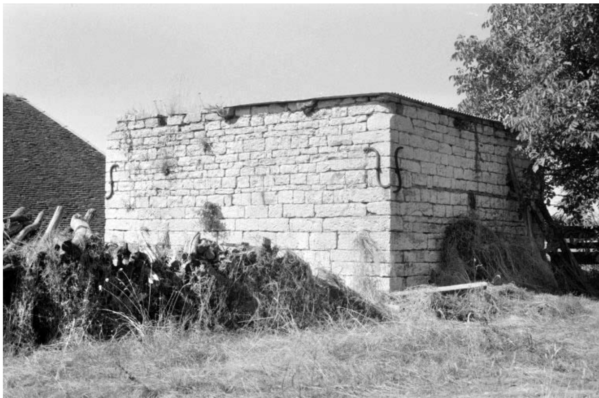
Façade postérieure du four industriel. L'ouverture du foyer se trouve en contrebas, sur la façade antérieure, face à la halle de séchage.
