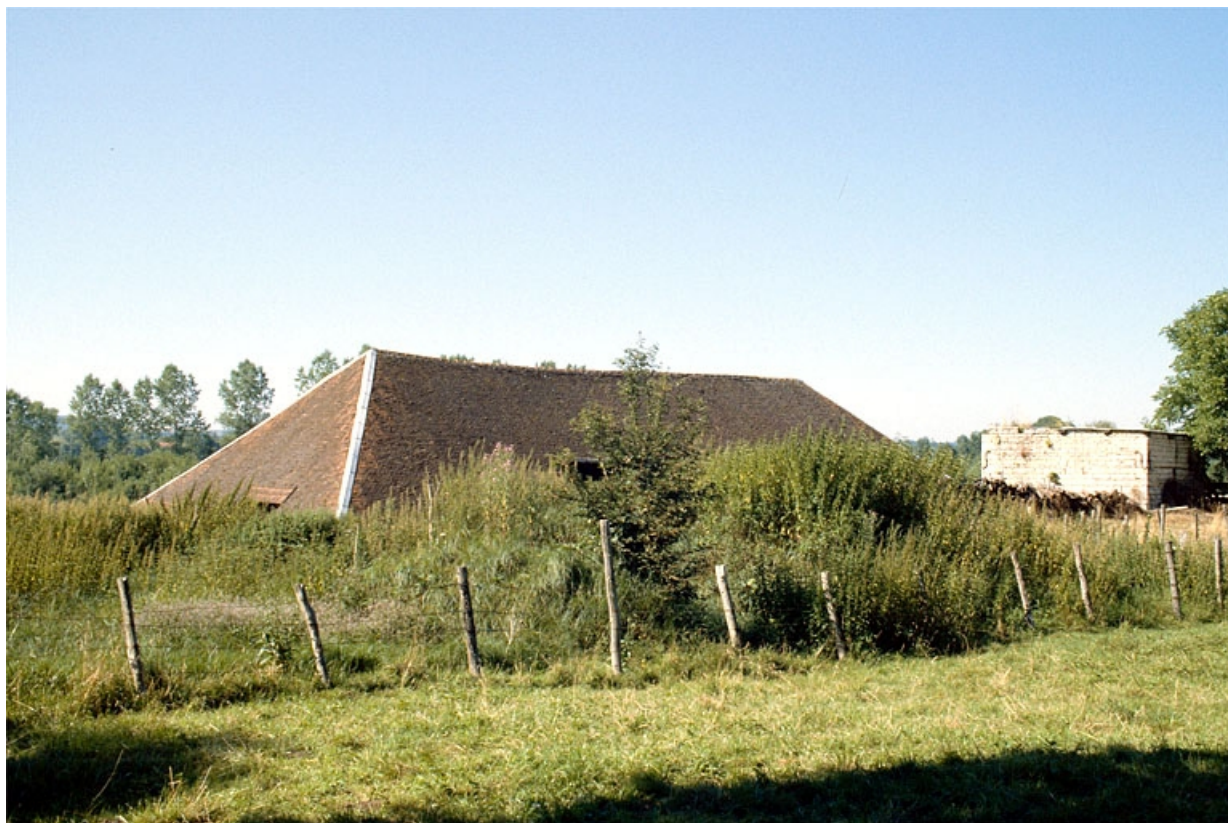
Vue d'ensemble de la halle de séchage et du four, depuis le sud.
