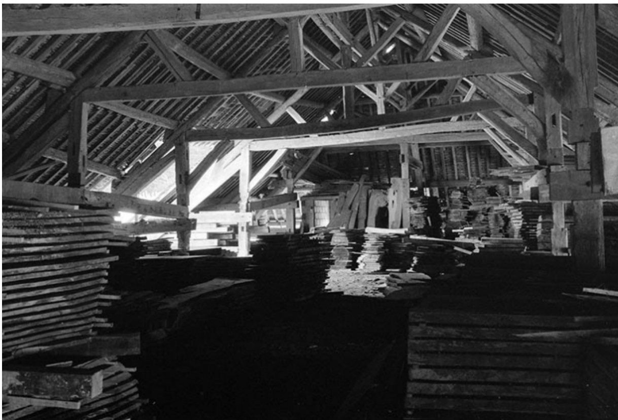
Intérieur de la halle de séchage.
