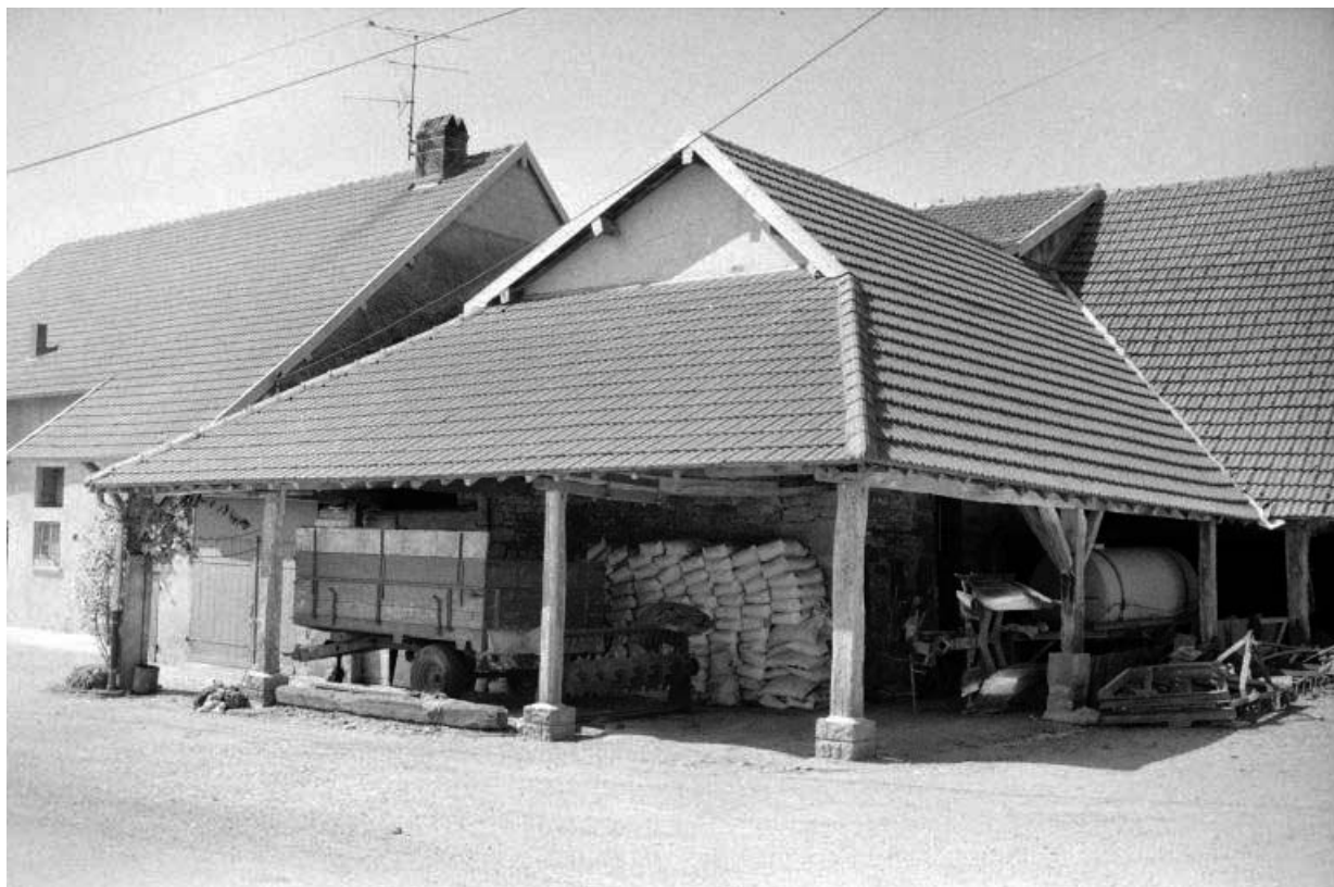
Corps de bâtiment abritant le 1er four.
