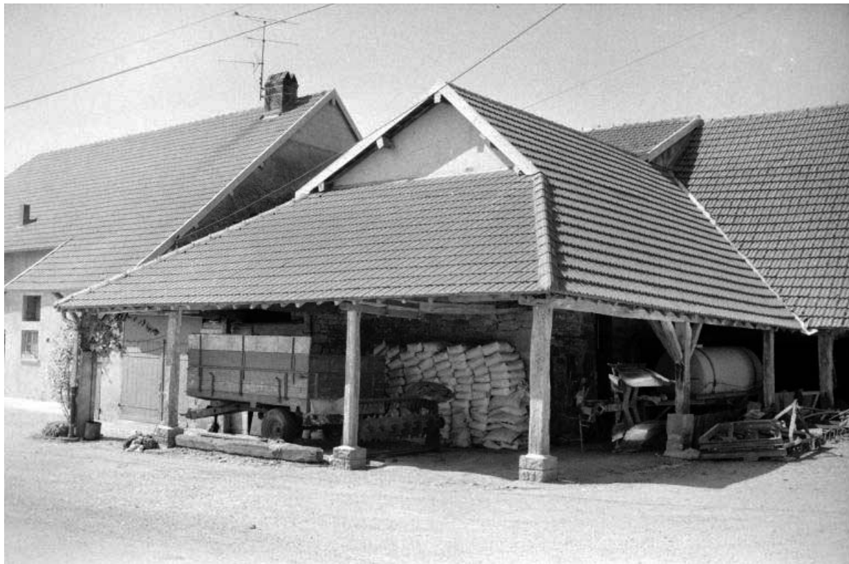
Corps de bâtiment abritant le 1er four.
