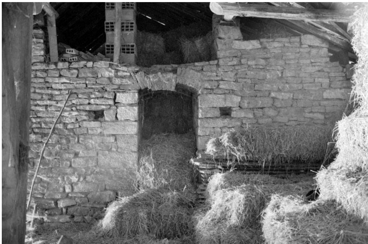
Porte d'enfournement du 2e four (four intérieur).
