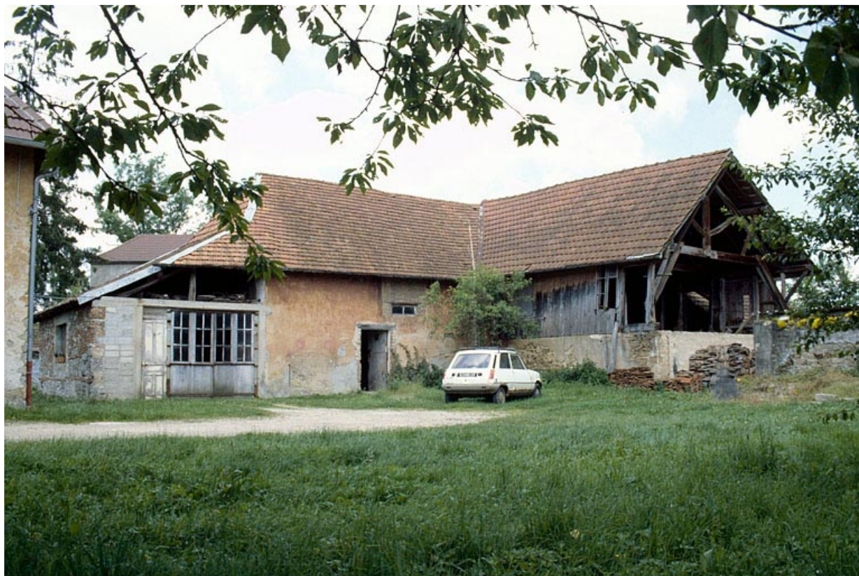
Atelier de fabrication (B), depuis le sud-est. 39, Vaudrey
