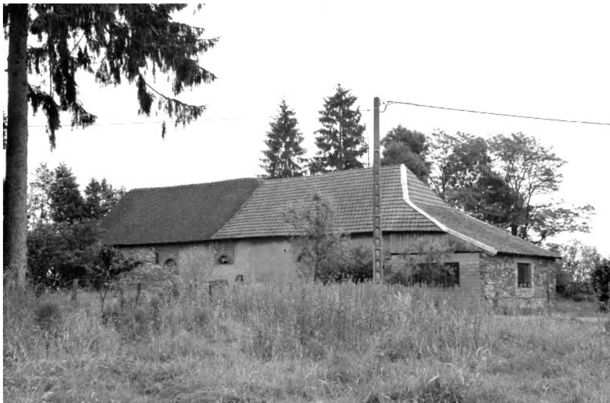
Atelier de fabrication (B), depuis le sud-ouest.
