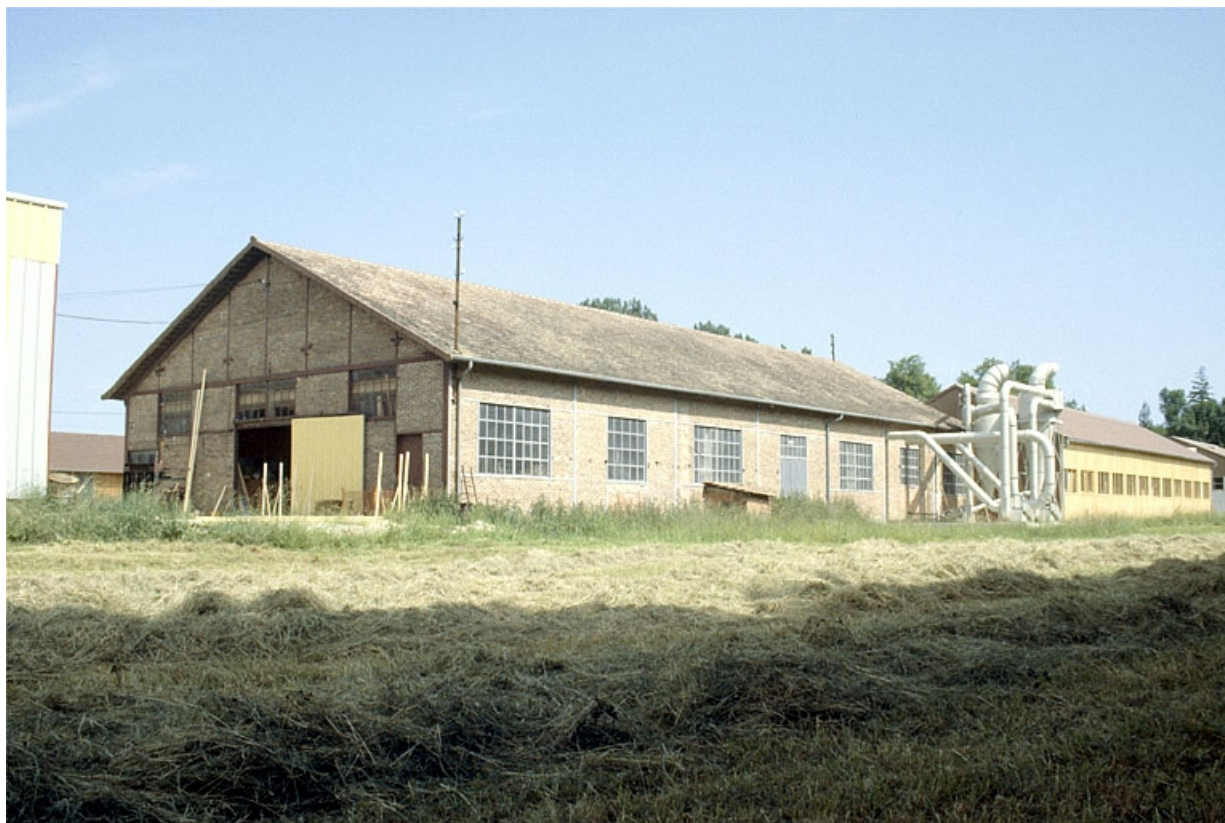
Atelier de fabrication (K), depuis le sud.
