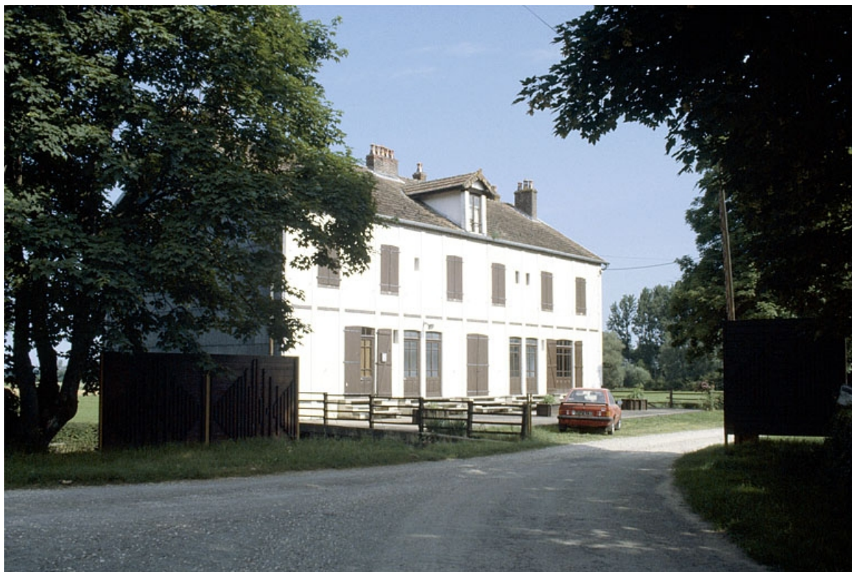
Logement d'ouvriers (O), depuis l'entrée de l'usine.
