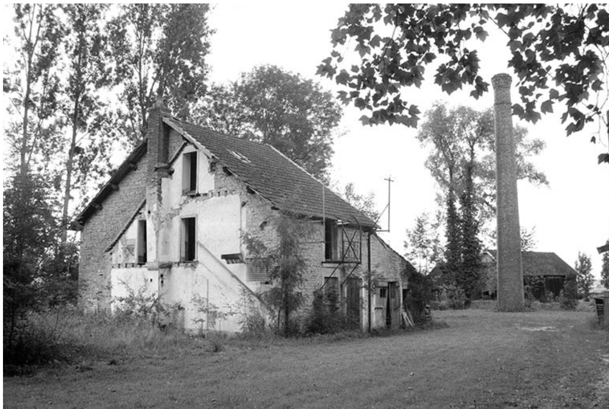
Ecuries (G) et cheminée d'usine (F).
