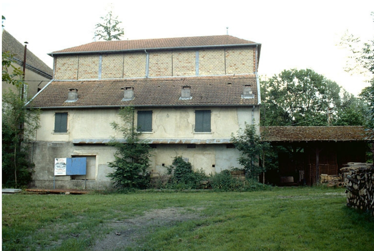
Façade latérale droite de l'atelier de fabrication (D).
