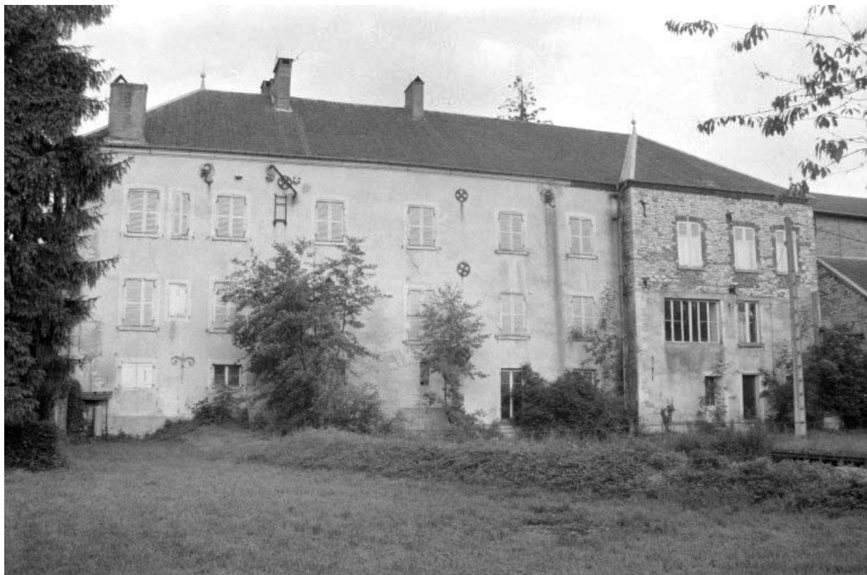
Salle des machines, bureau et logement patronal (C).
