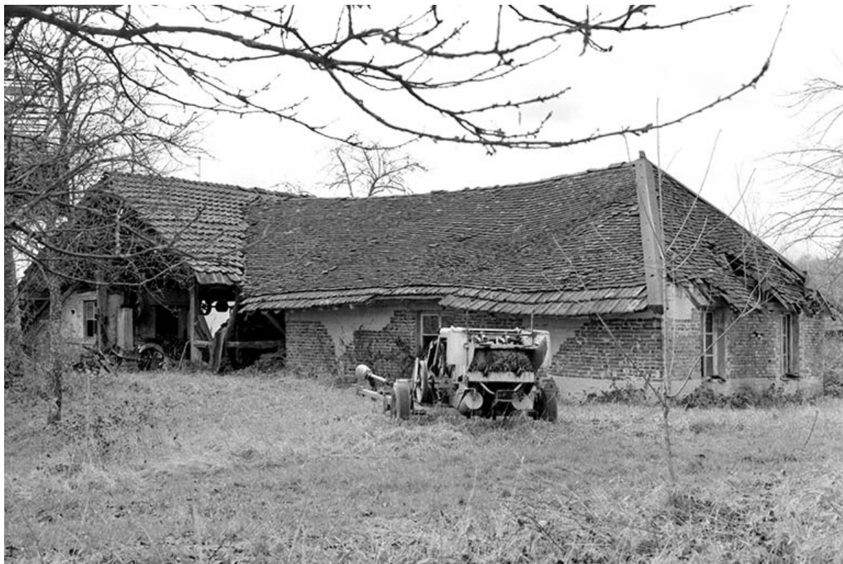
Atelier de fabrication et pièce de séchage : extrémité orientale. À gauche sous la halle, pièce contenant le moteur Bernard et sa transmission.
