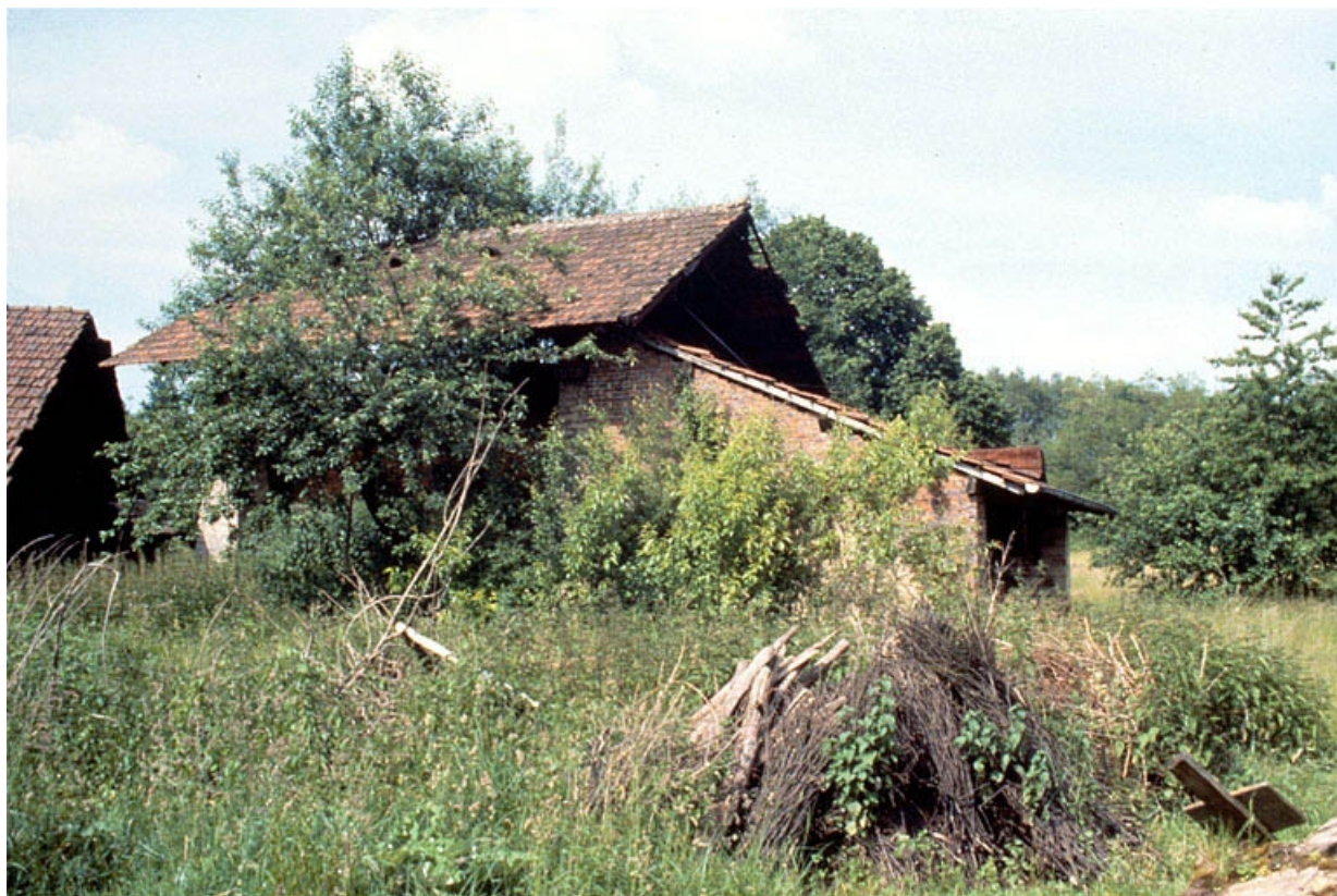
Bâtiment du four (C), depuis le sud.
