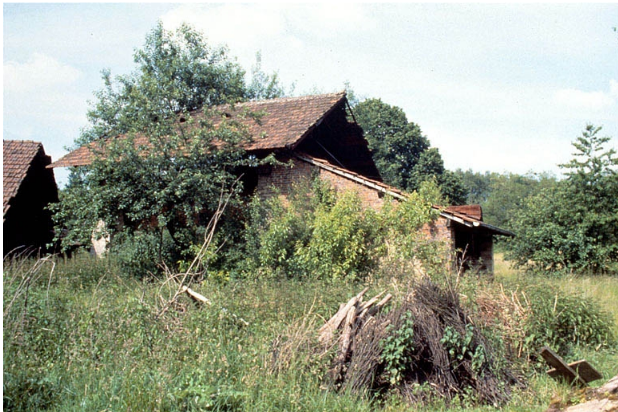
Bâtiment du four (C), depuis le sud.
