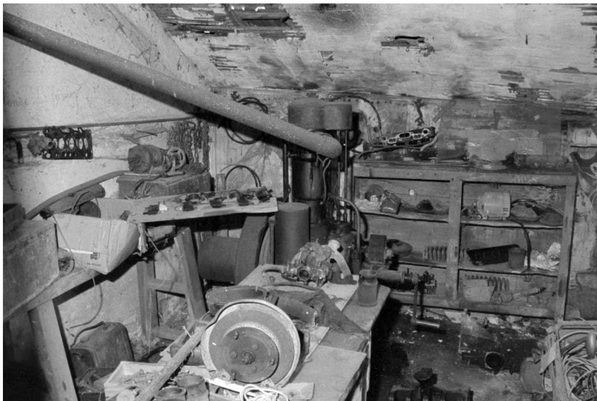
Atelier de fabrication et pièce de séchage : moteur Bernard.
