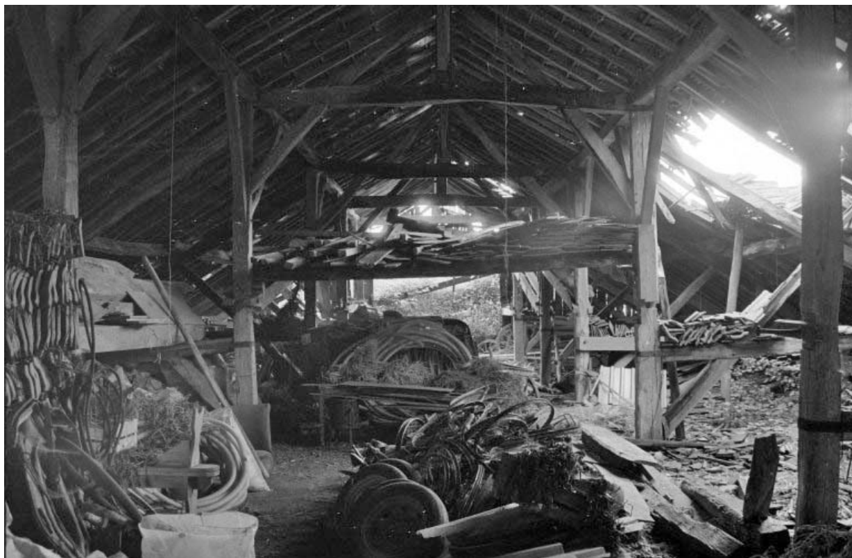
Atelier de fabrication et pièce de séchage : intérieur.
