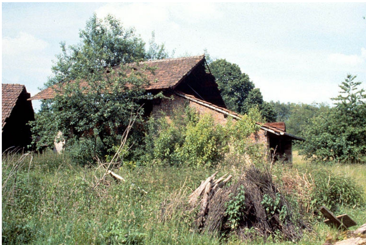
Bâtiment du four (C), depuis le sud.
