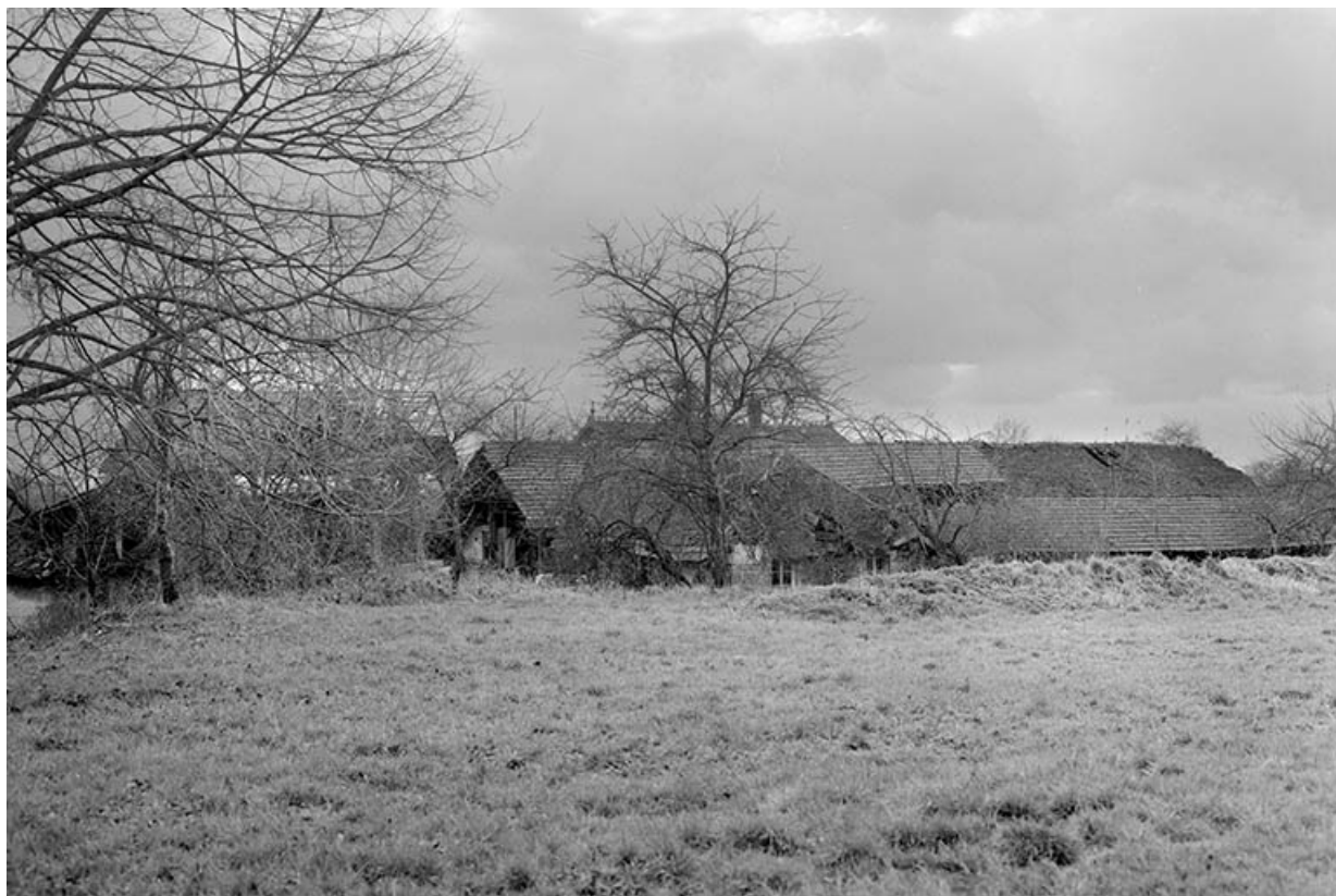
Atelier de fabrication et pièce de séchage (B), depuis le nord.
