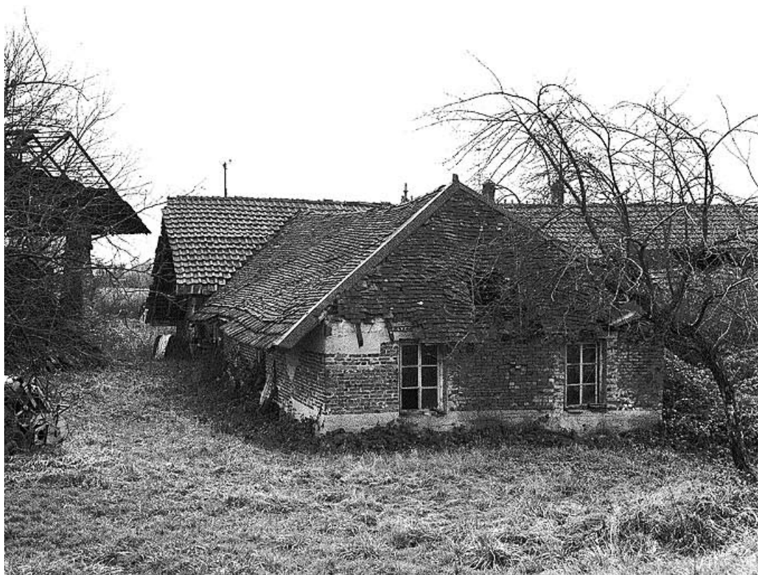
Atelier de fabrication et pièce de séchage : détail de l'aile en retour au nord. 39, Santans, lieudit : la Vigne
