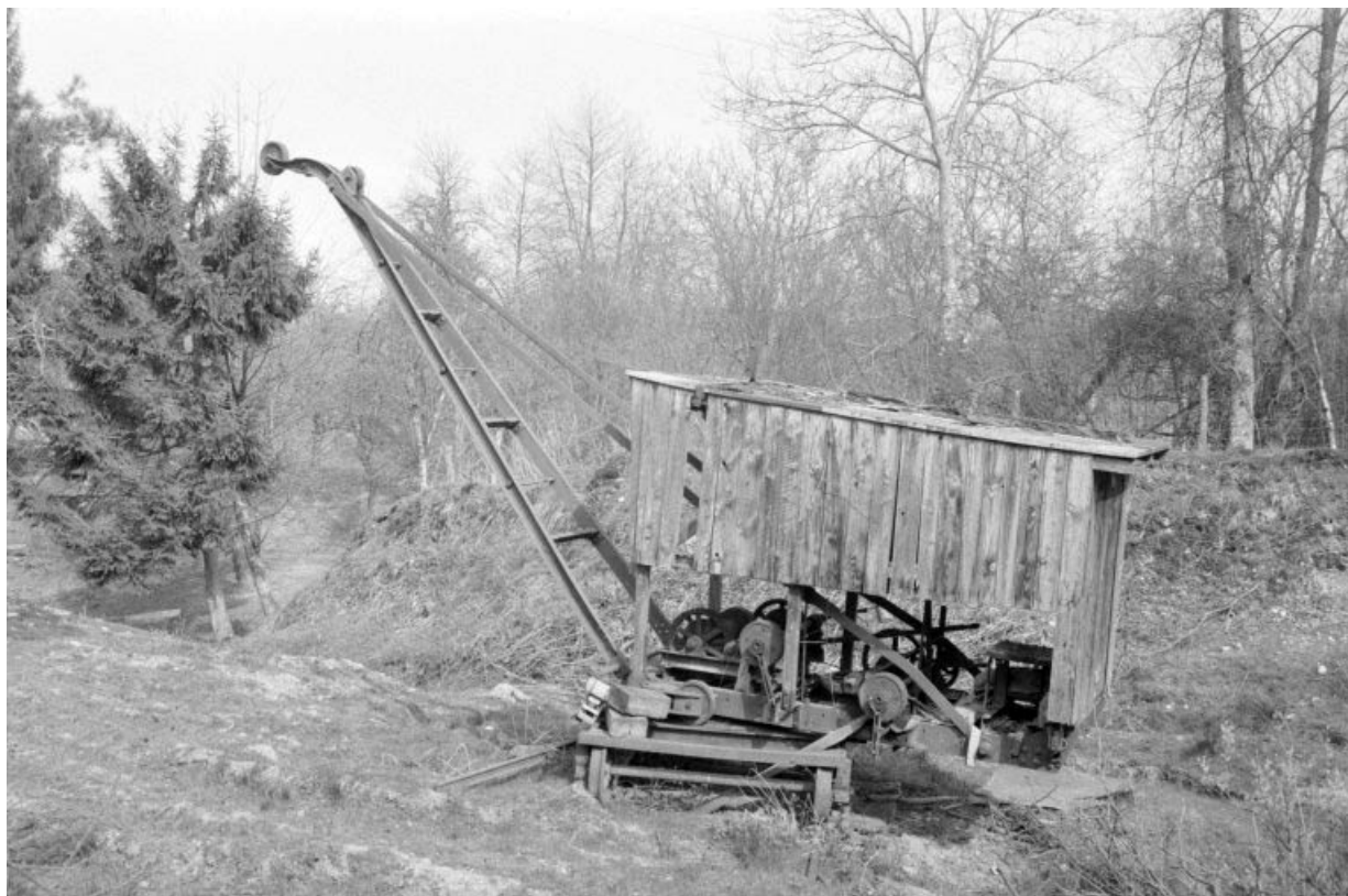
Grue sur voie étroite dans l'ancienne carrière.
