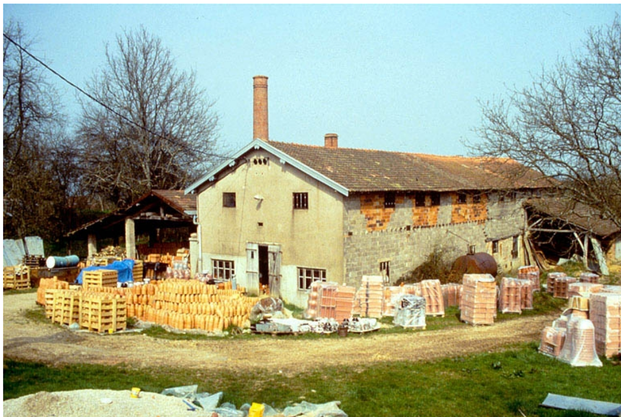
Façades antérieure et latérale droite.
