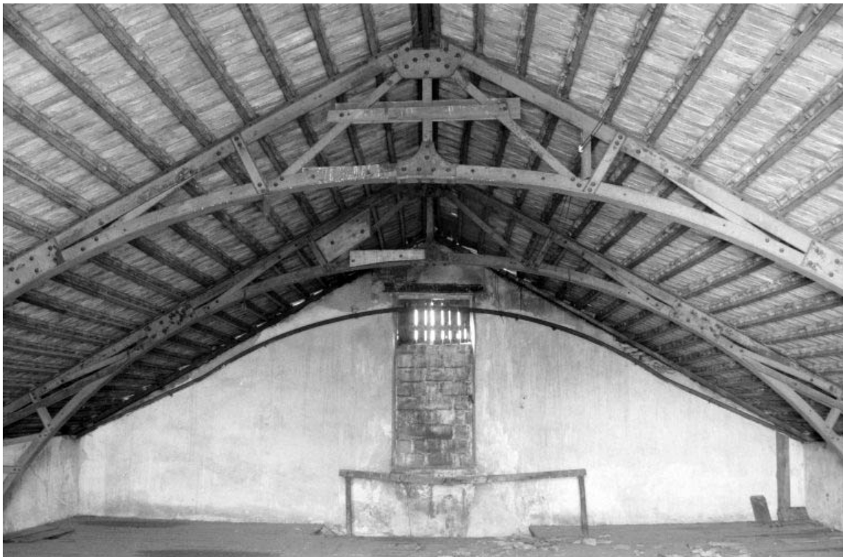
Ancien atelier de fabrication (b2), étage en surcroît : détail de la charpente et mur pignon ouest. 39, Salans, lieudit : le Moulin du Pré
