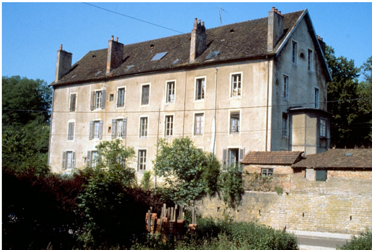
Façade postérieure vue de trois quarts droit. 39, Fraisans rue de l' Eglise
