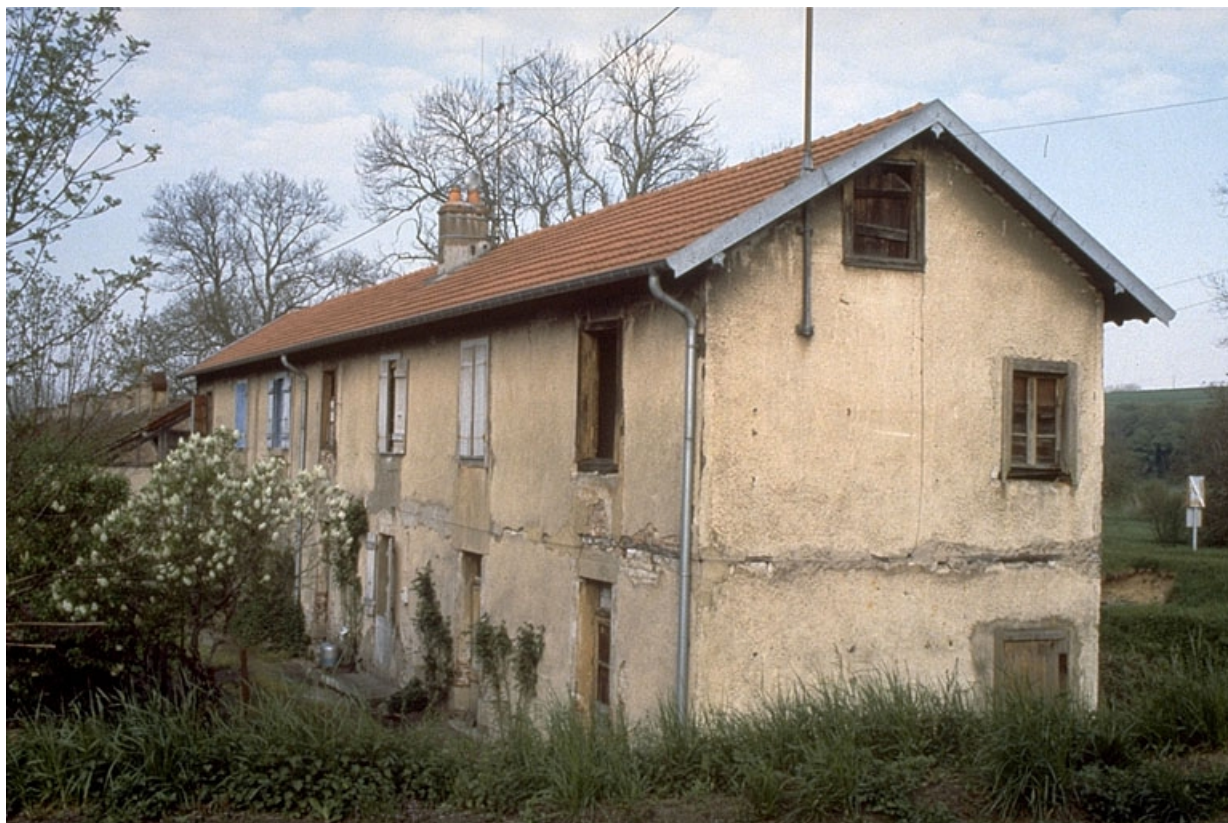
Bâtiment à étage : façades antérieure et latérale droite.
