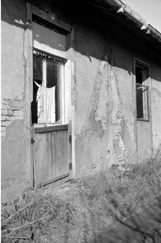
Bâtiment en rez-de-chaussée : détail de la façade antérieure.
