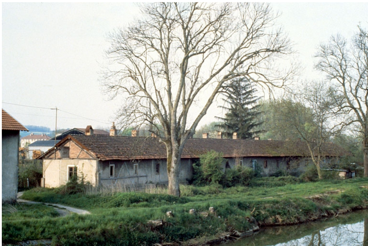
Bâtiment en rez-de-chaussée : façades postérieure et latérale droite.
