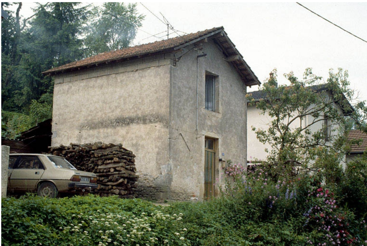
Maison n° 36, rue de Salans vue de trois quarts gauche.
