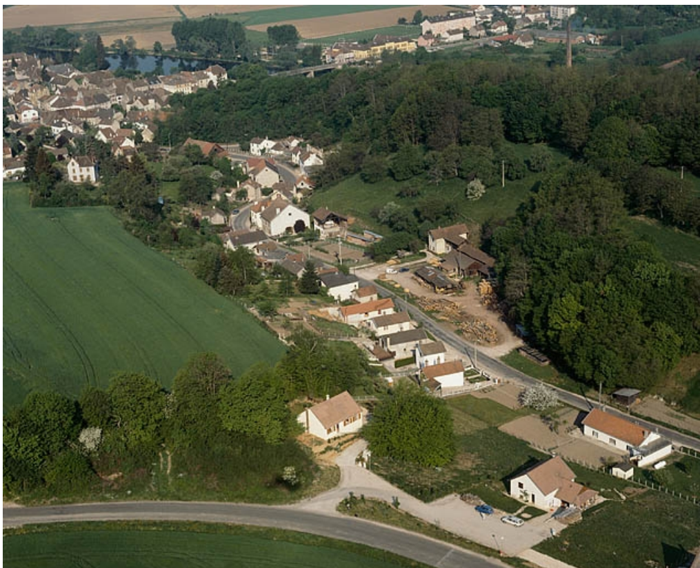
Vue d'ensemble depuis l'est, photographie aérienne.
