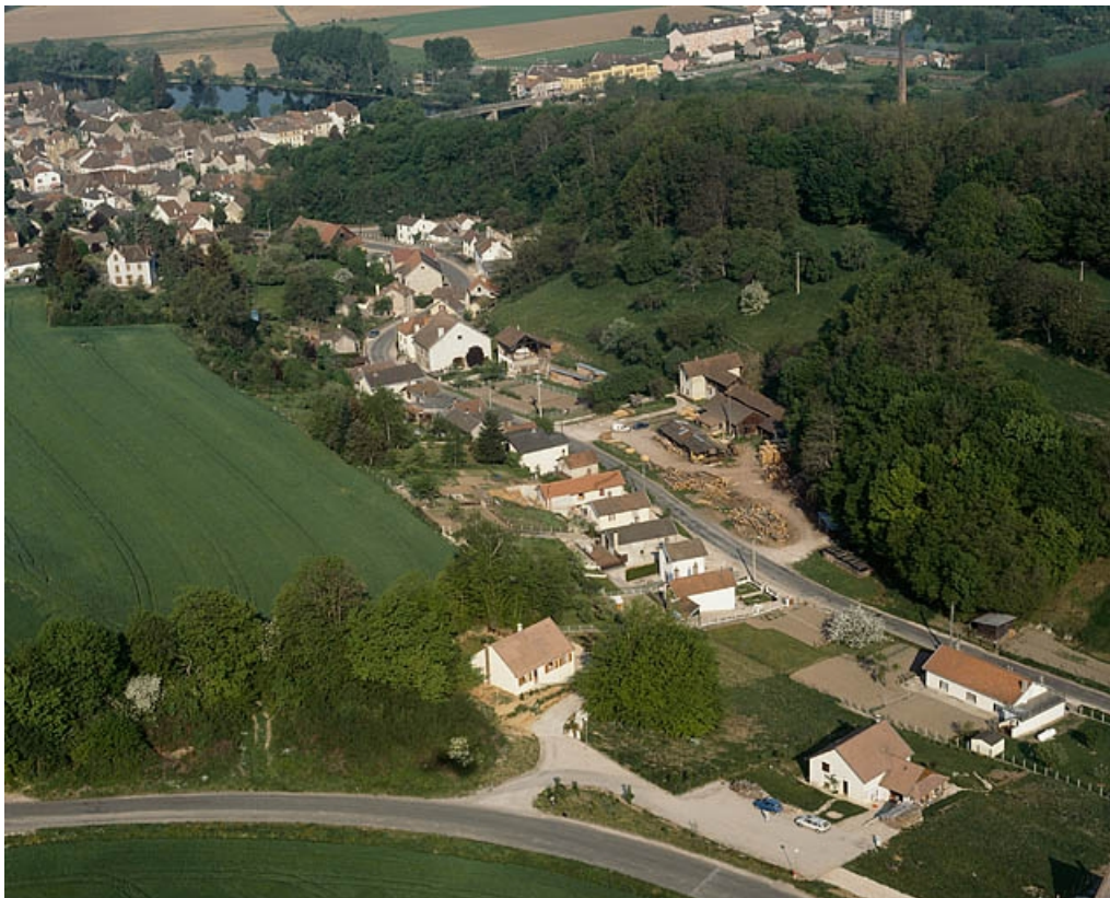
Vue d'ensemble depuis l'est, photographie aérienne.
