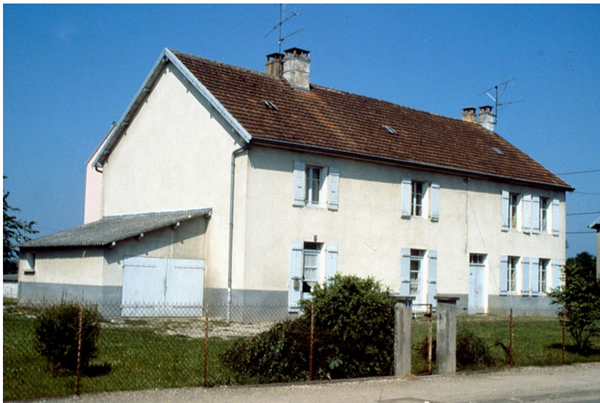
Maison n° 7, rue de la Gare (ancien hôpital) vue de trois quarts gauche. 39, Fraisans, 5 à 13 rue de la Gare
