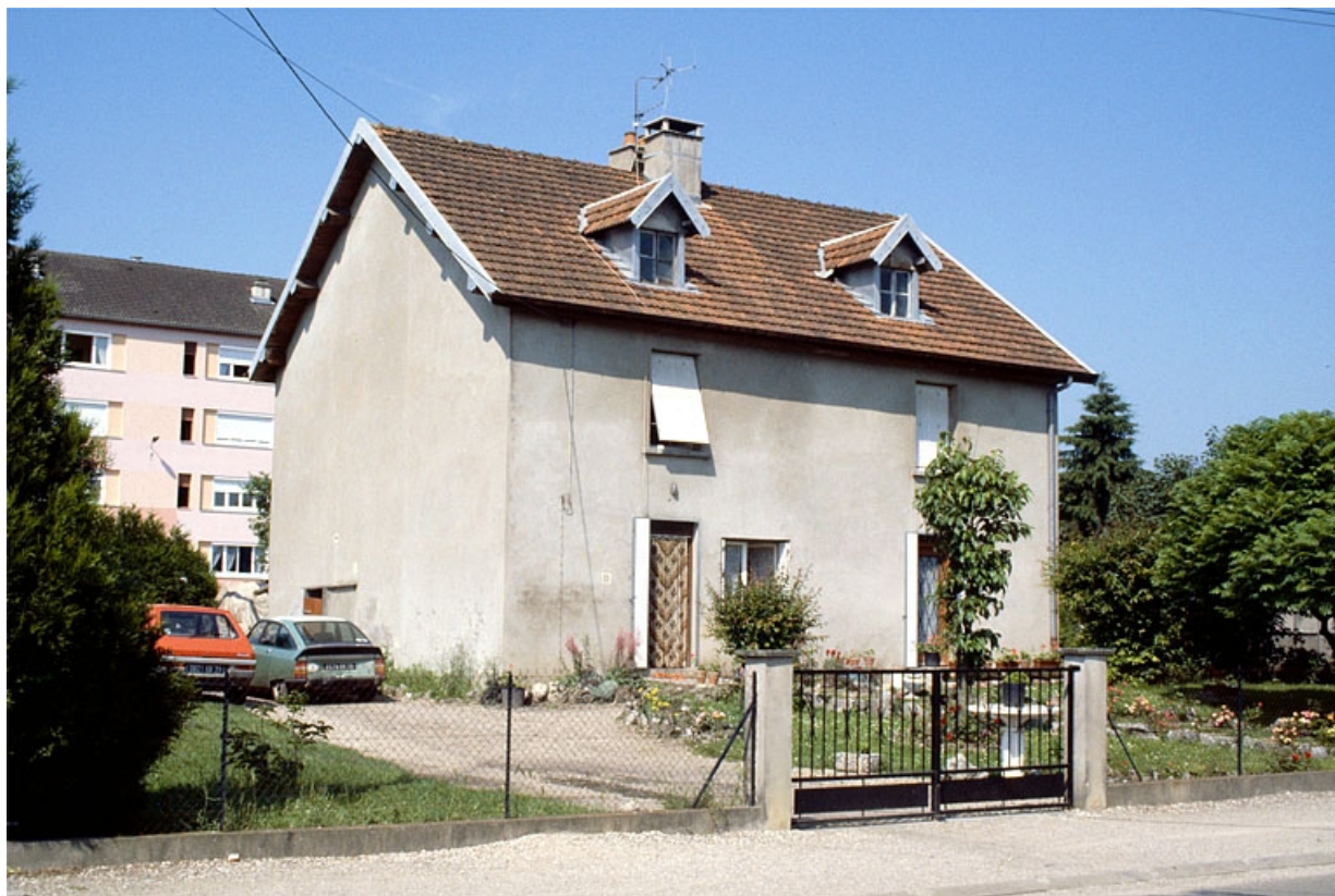
Maison n° 9, rue de la Gare vue de trois quarts gauche.
