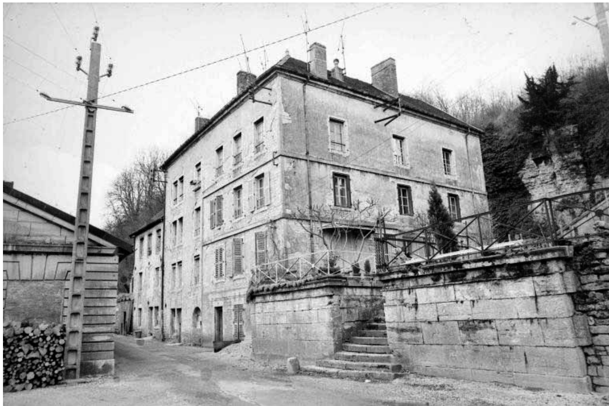
Vue d'ensemble. Logements ouvriers à gauche et logements de contremaîtres à droite (rive gauche). 39, Fraisans, 18 rue de la Vieille Forge
