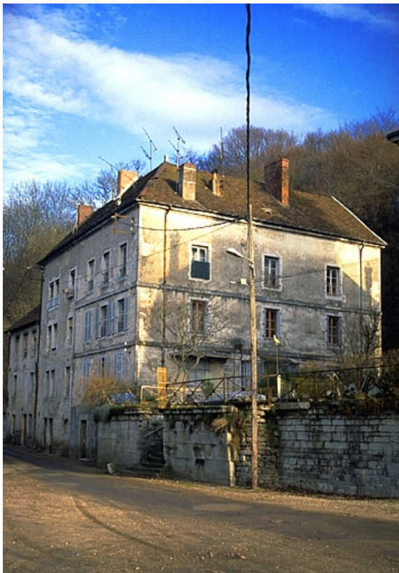
Façades antérieure et latérale gauche du logement de contremaître.
