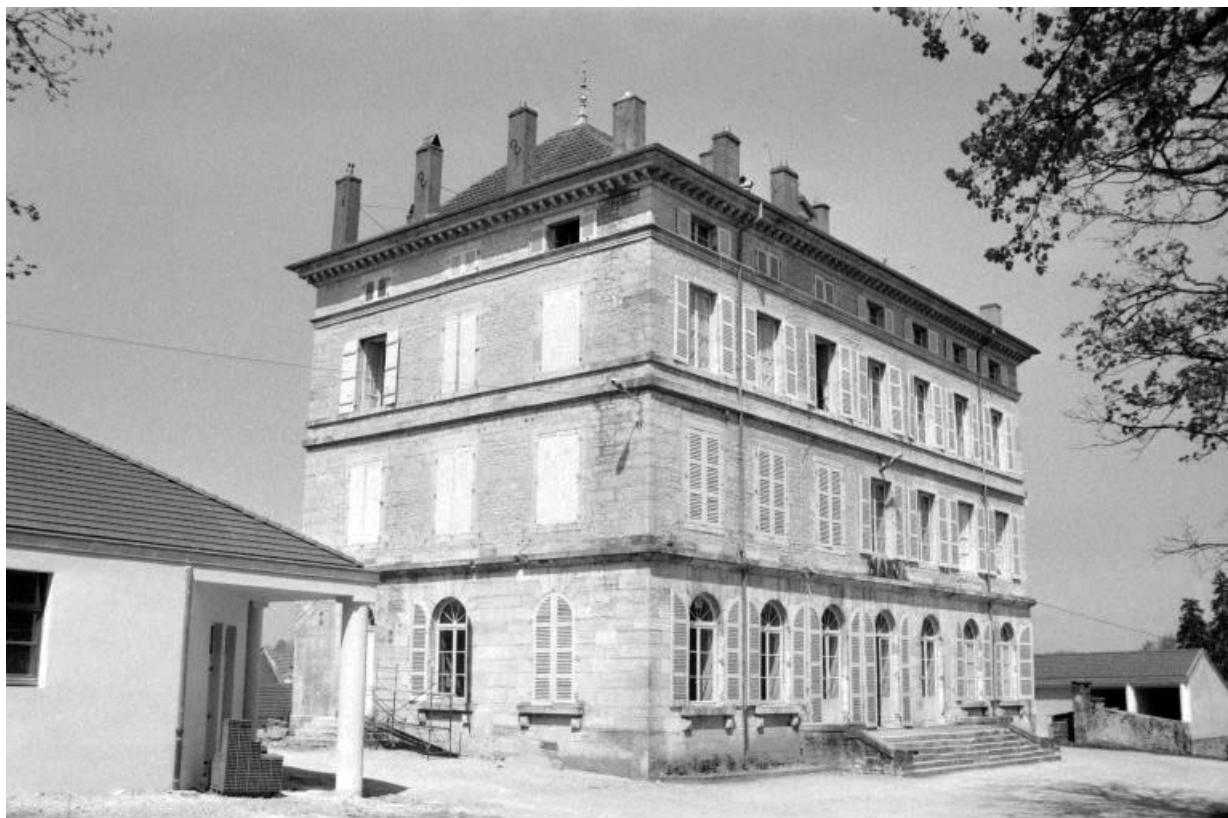
Logement patronal vu de trois quarts gauche. 39, Fraisans rue de l' Eglise
