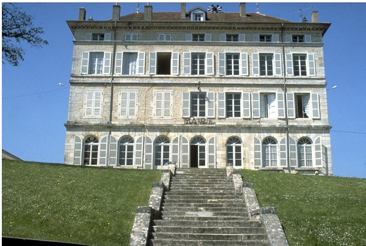
Façade antérieure du logement patronal.
