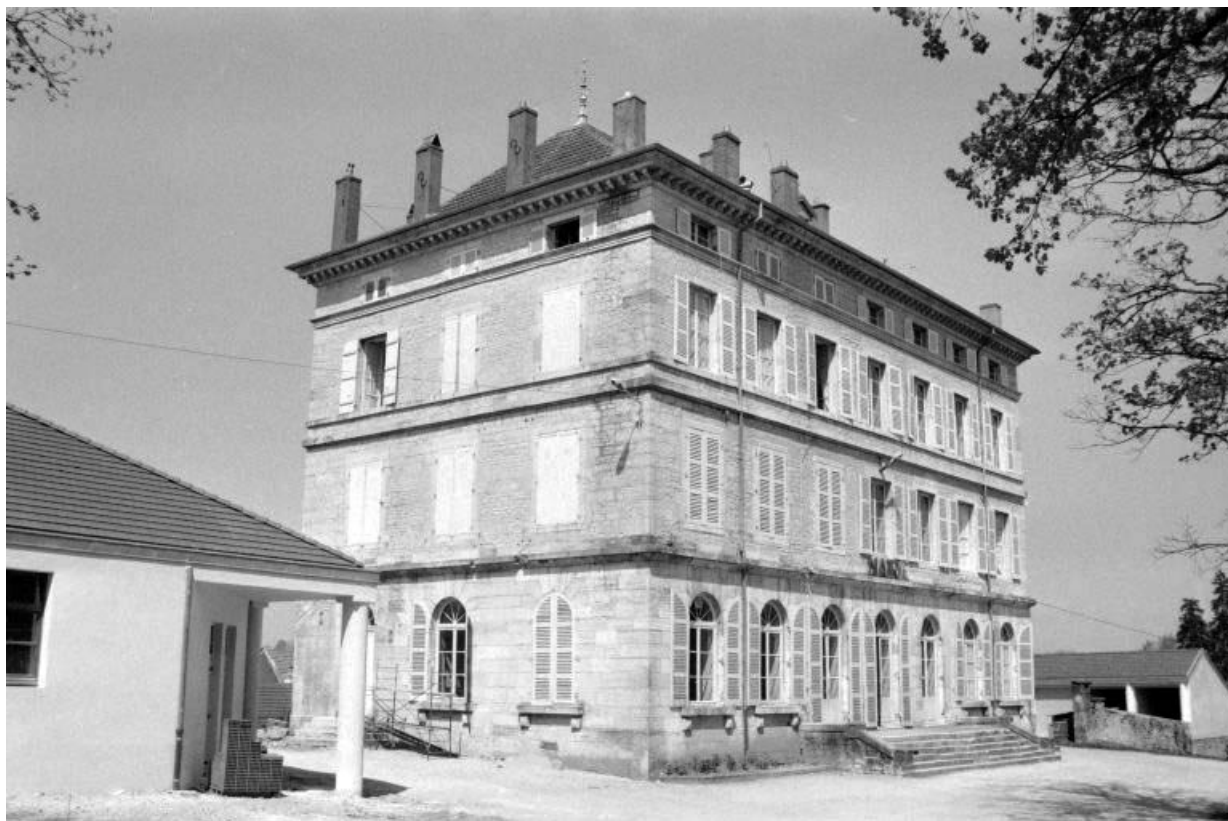
Logement patronal vu de trois quarts gauche.
