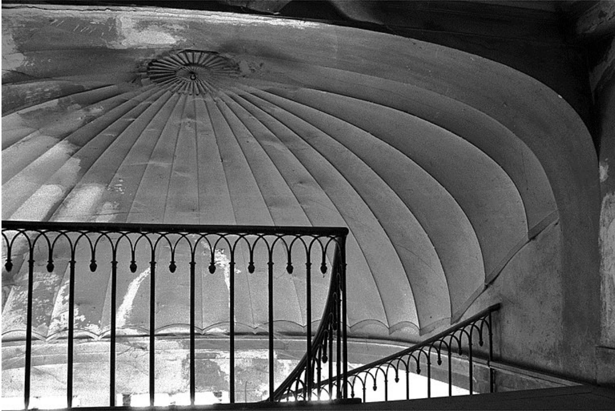
Fausse voute en cul de four de l'escalier tournant.
