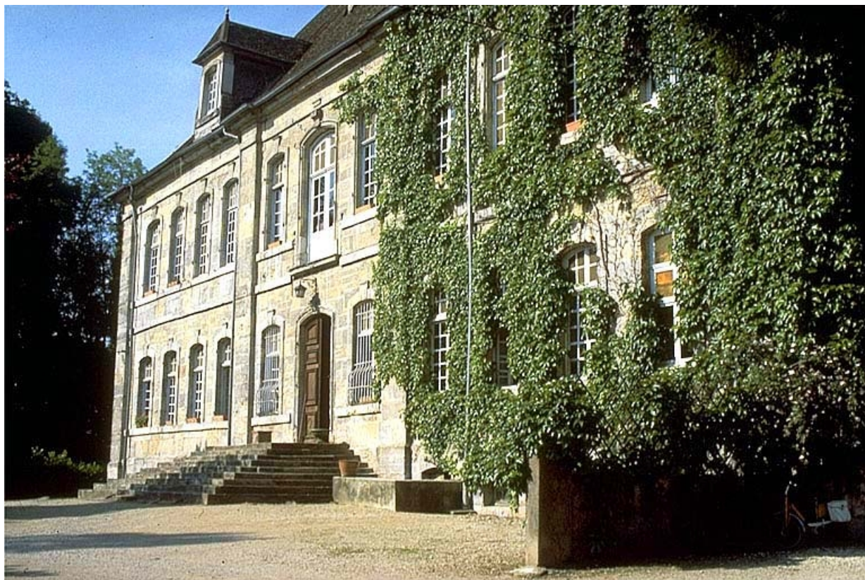
Façade antérieure du logement patronal, vue de trois quarts droit.
