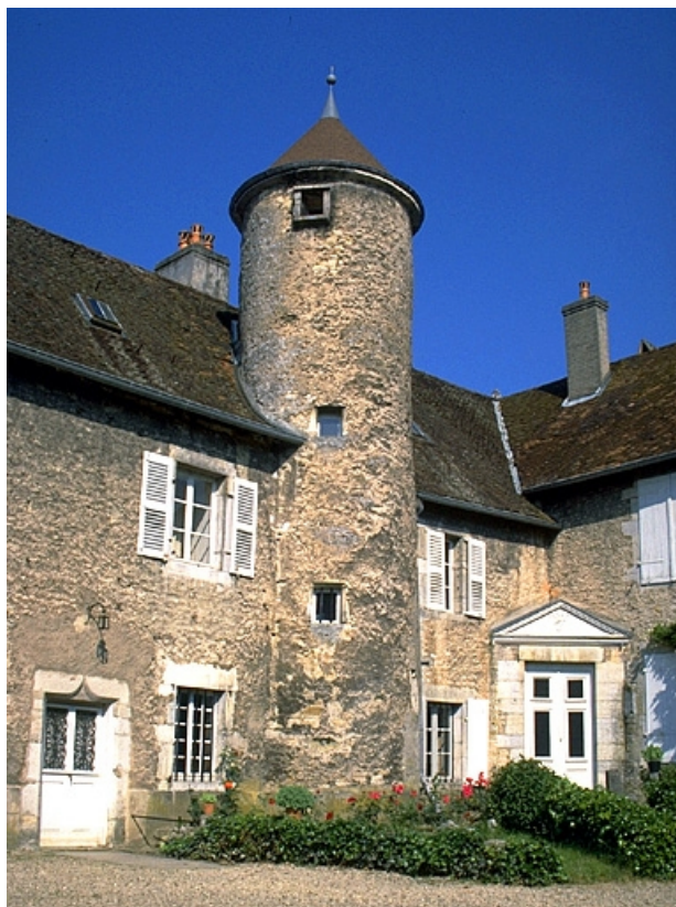
Façade antérieure du logement patronal.
