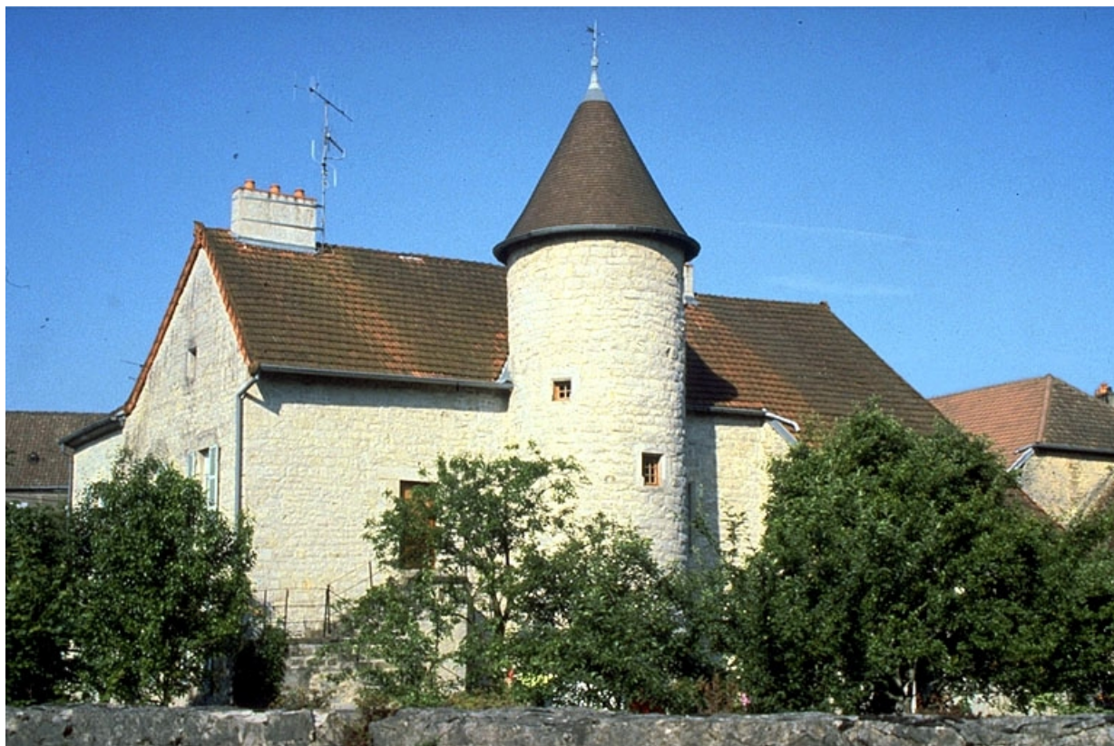
Façade postérieure vue de trois quarts gauche.
