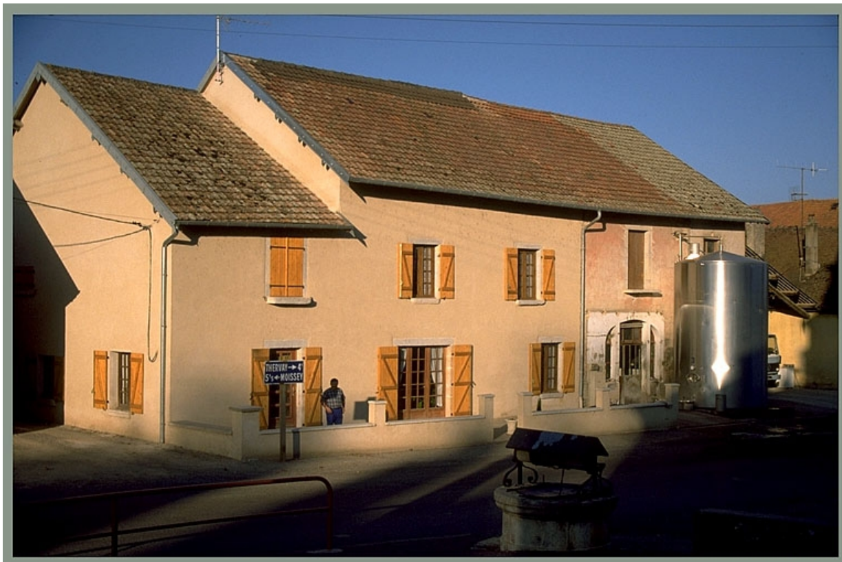
Façade antérieure vue de trois quarts gauche. 39, Brans
