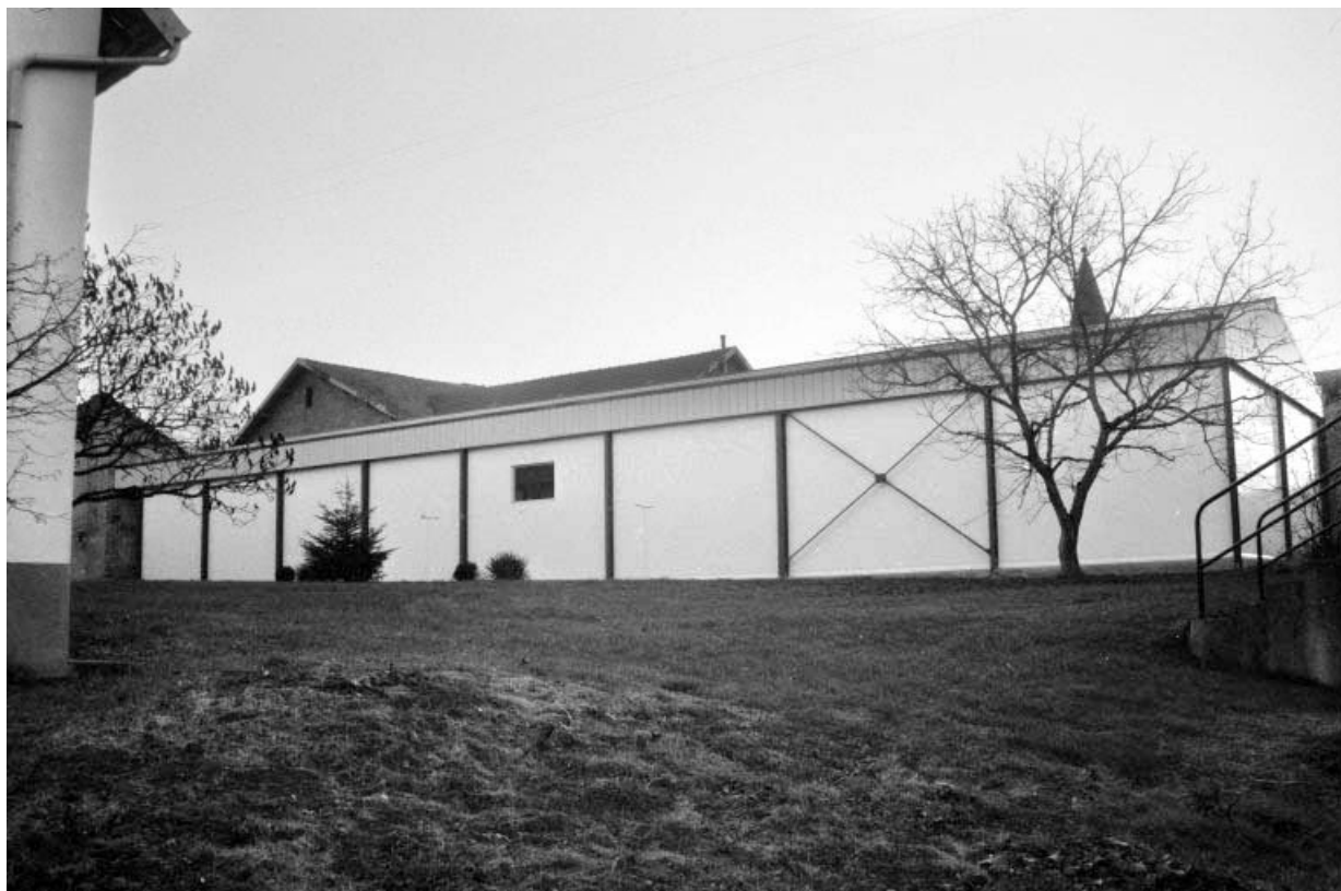
Cave d'affinage (E) vue du nord-est. 39, Brans
