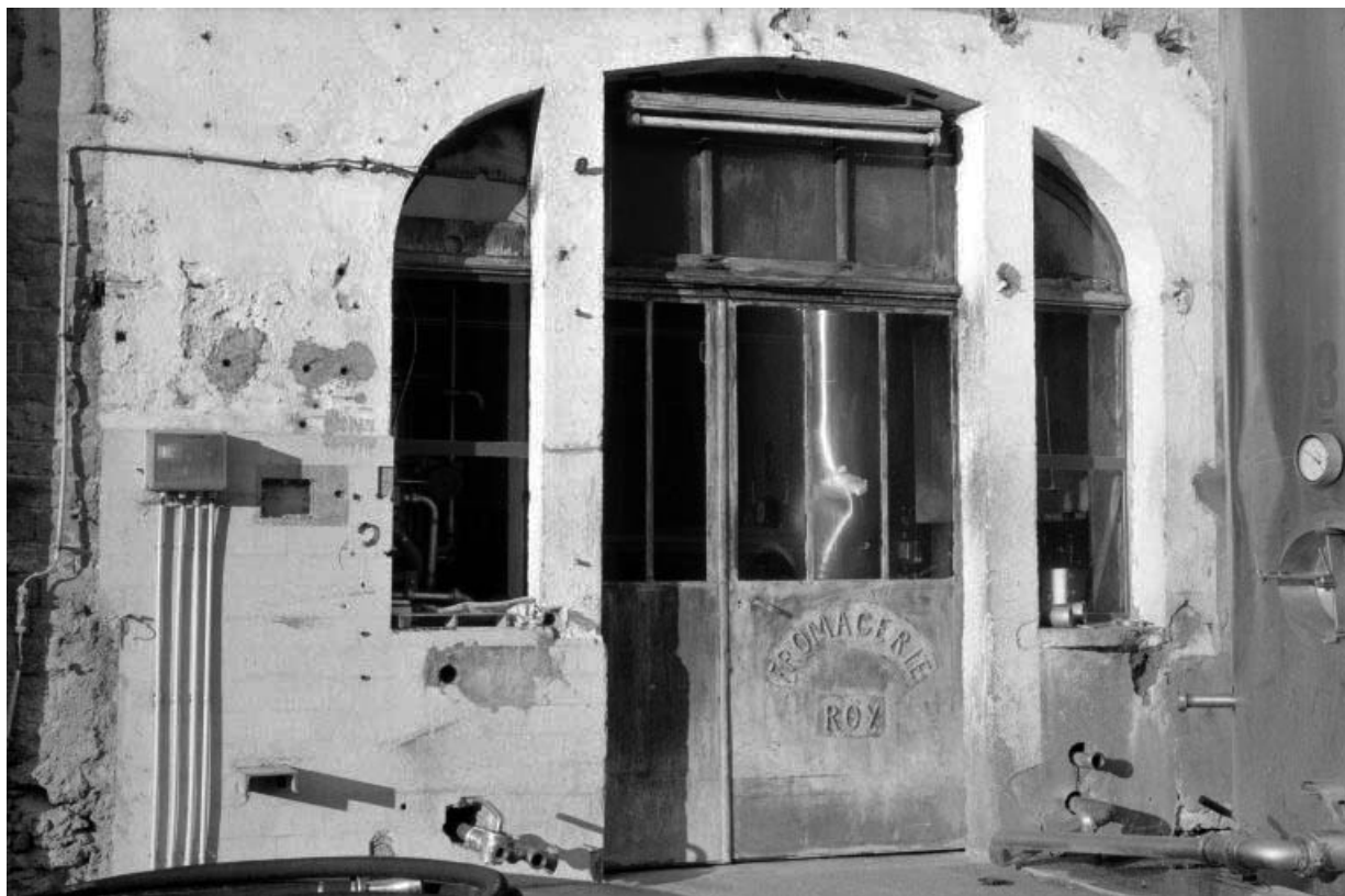
Porte d'entrée de l'atelier de fabrication.
