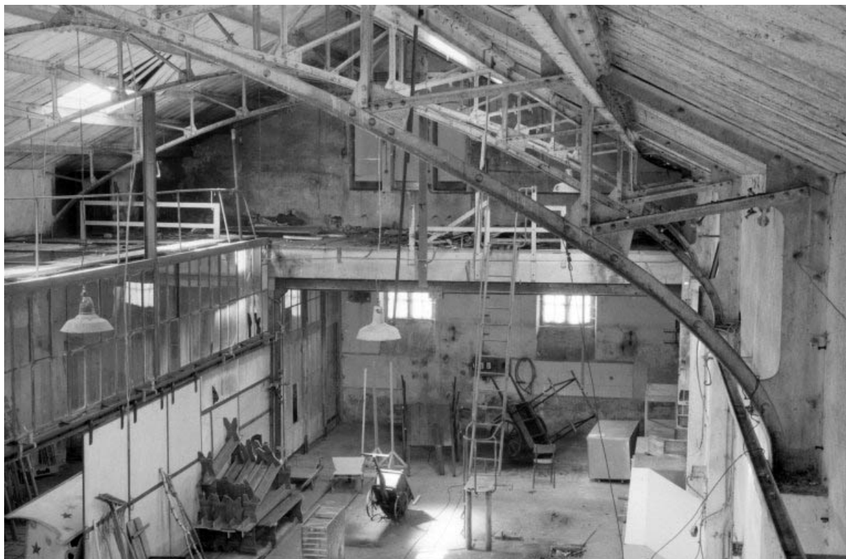
Intérieur de l'atelier de fabrication, depuis le bureau.
