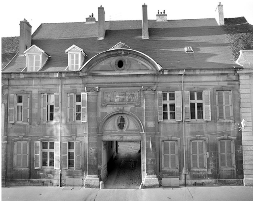
Façade antérieure de l'hôtel, vue de face.
