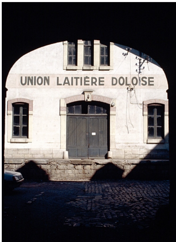
Façade antérieure de l'atelier de fabrication, depuis le porche d'entrée. 39, Dole, 76 rue des Arènes
