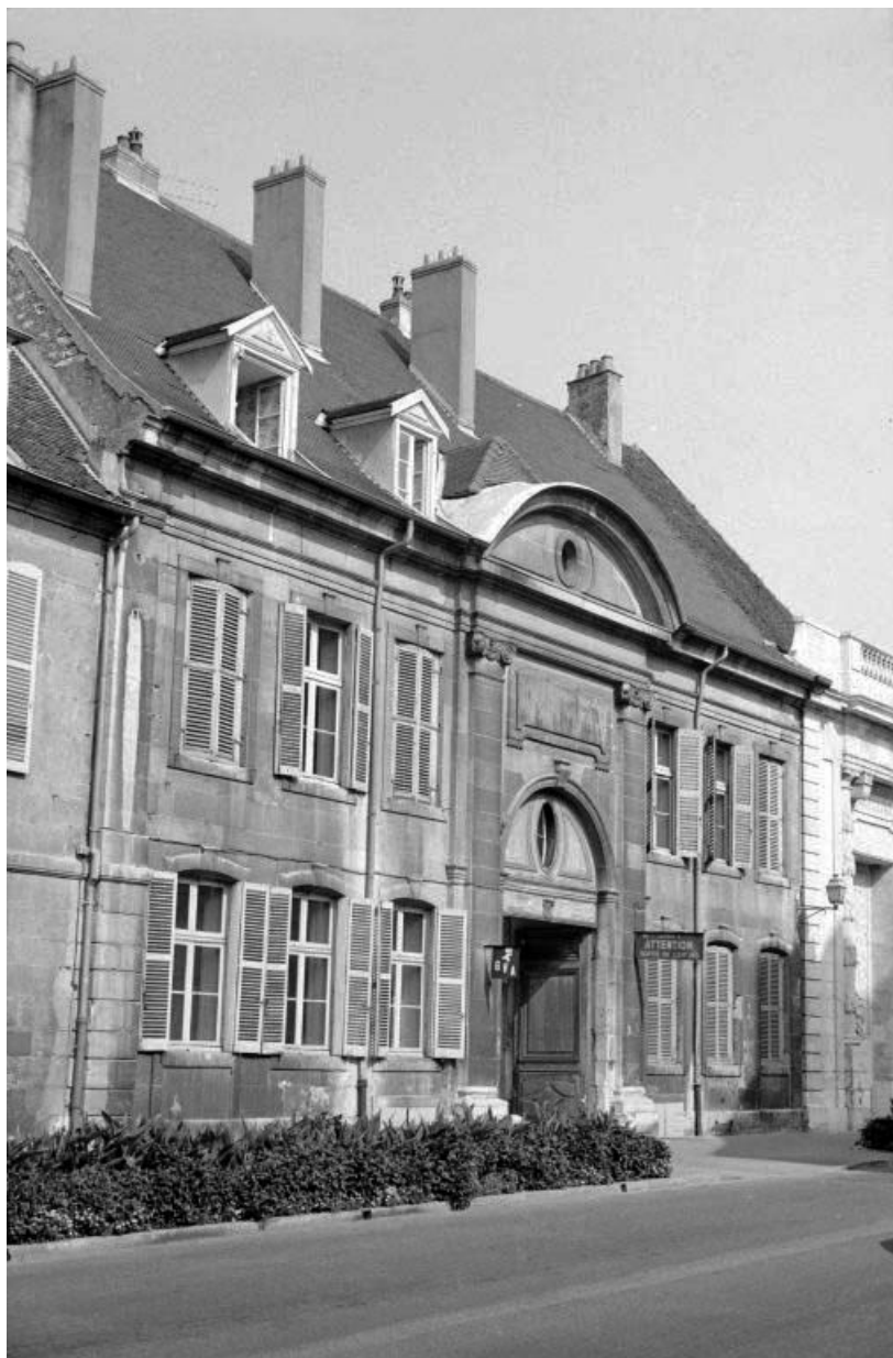
Façade antérieure de l'hôtel, vue de trois quarts gauche.
