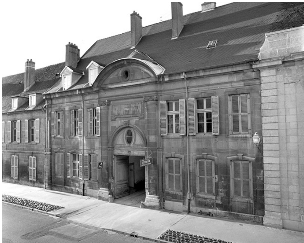
Façade antérieure de l'hôtel, vue de trois quarts droit.
