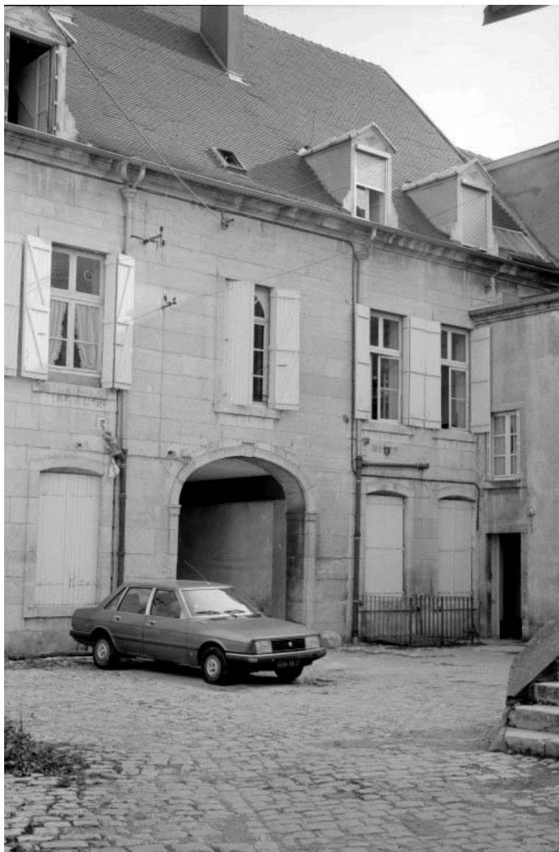
Façade postérieure de l'hôtel.
