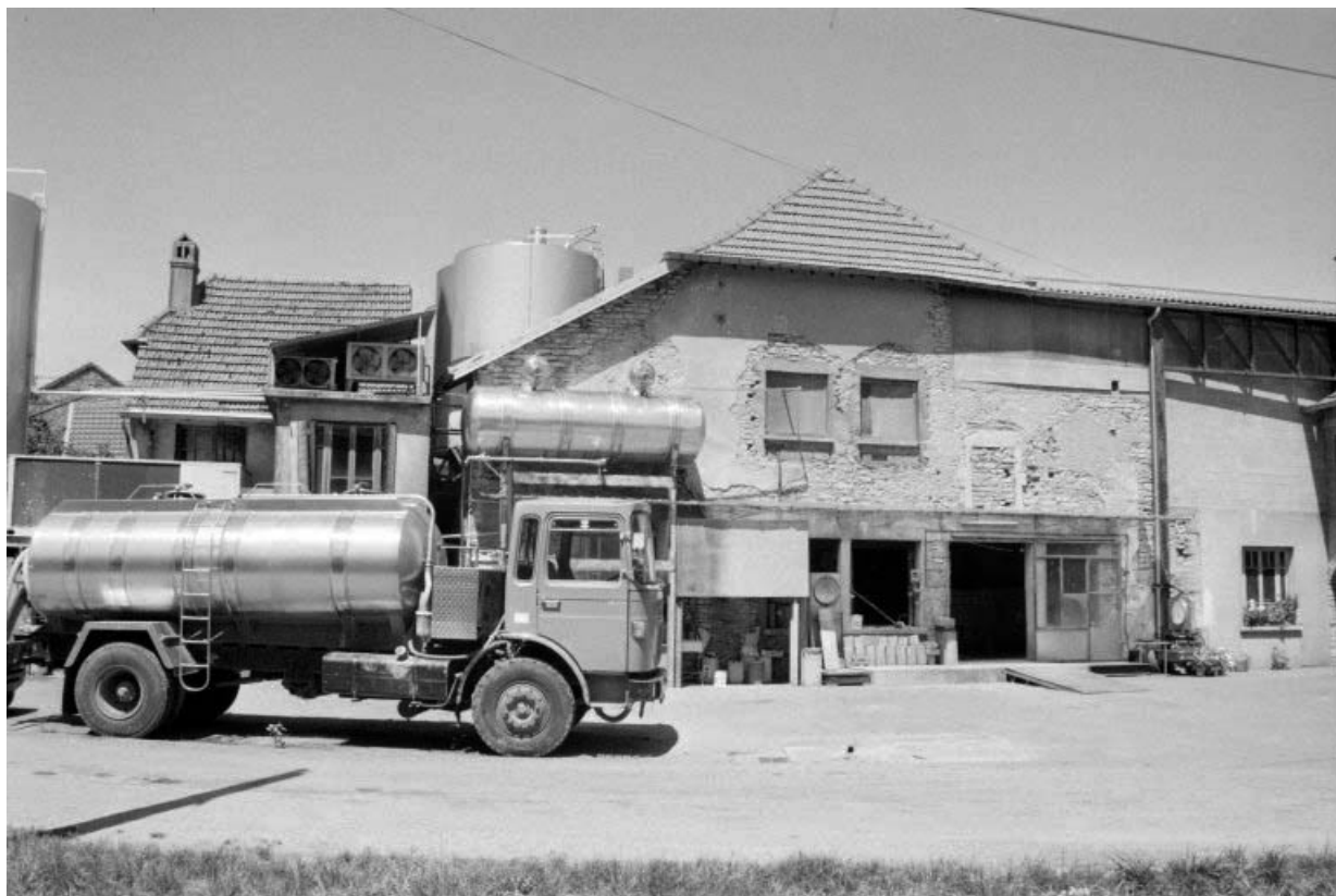
Façade antérieure de l'atelier de fabrication.
