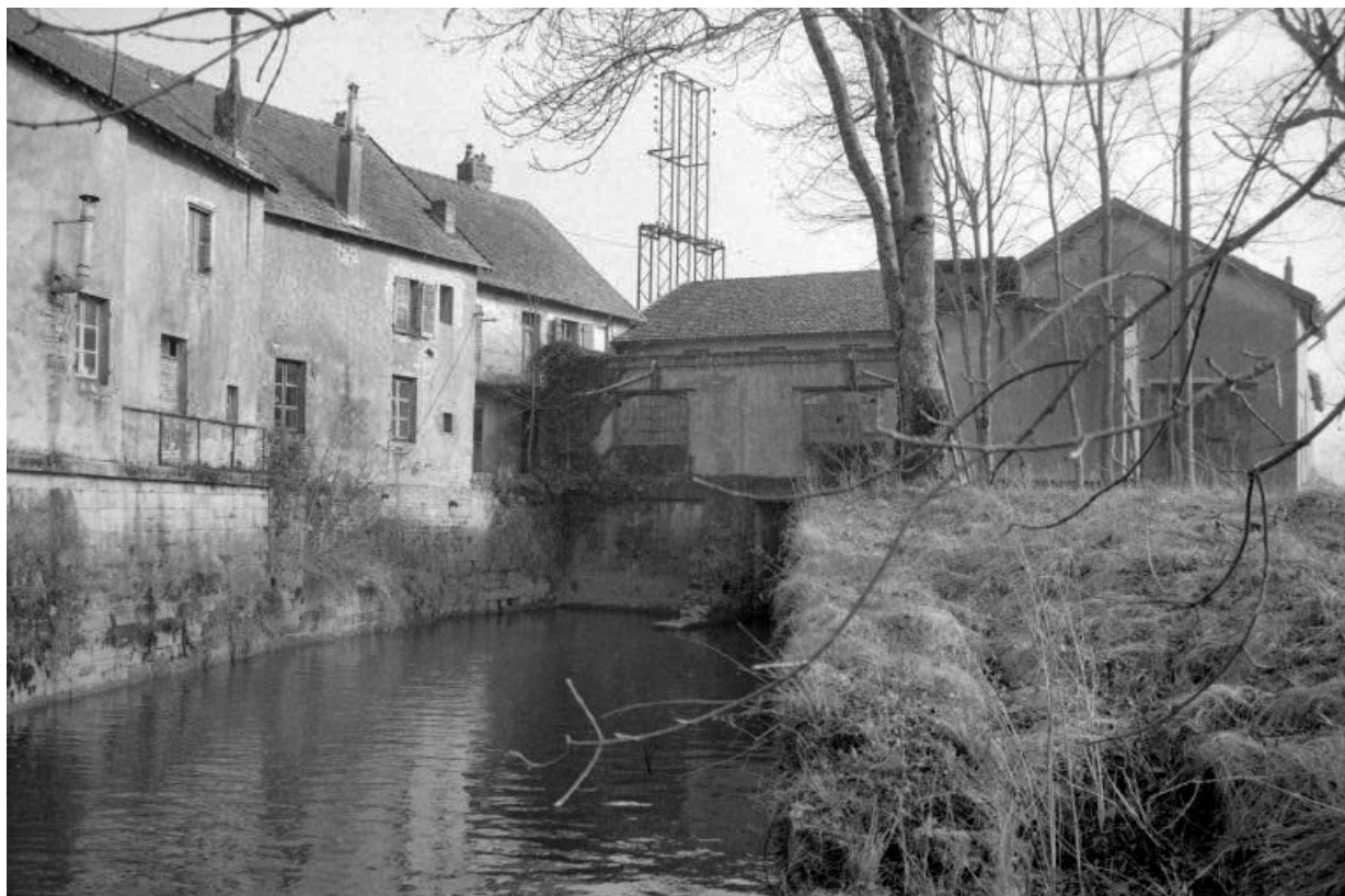
Maison, bâtiment d'eau et canal de fuite vus de l'ouest.
