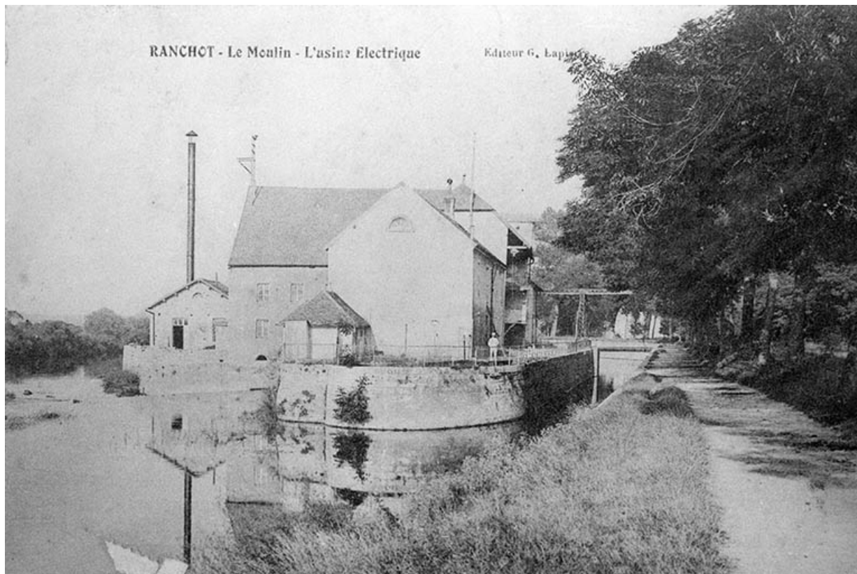
Ranchot. Le Moulin. L'usine électrique. 39, Ranchot, lieudit : le Moulin des Malades
