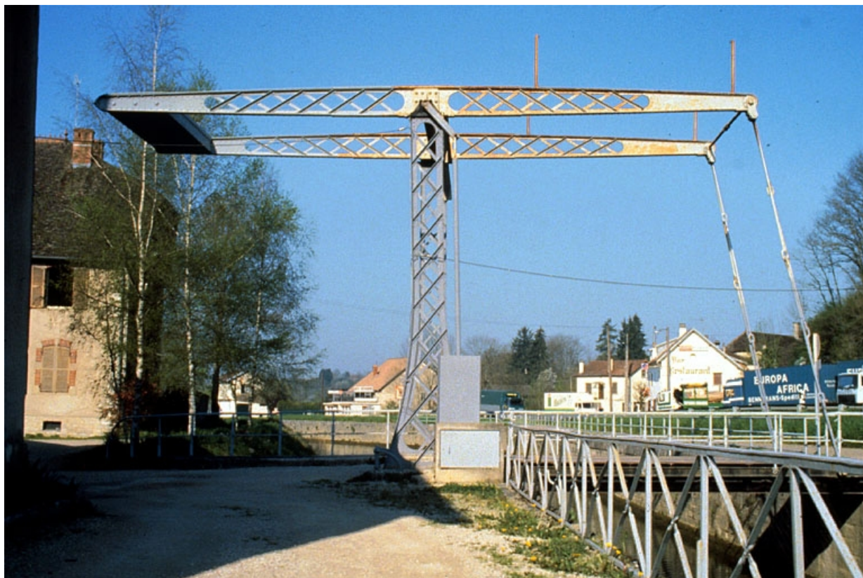
Pont-levis sur le Canal du Rhône au Rhin. 39, Ranchot, lieudit : le Moulin des Malades
