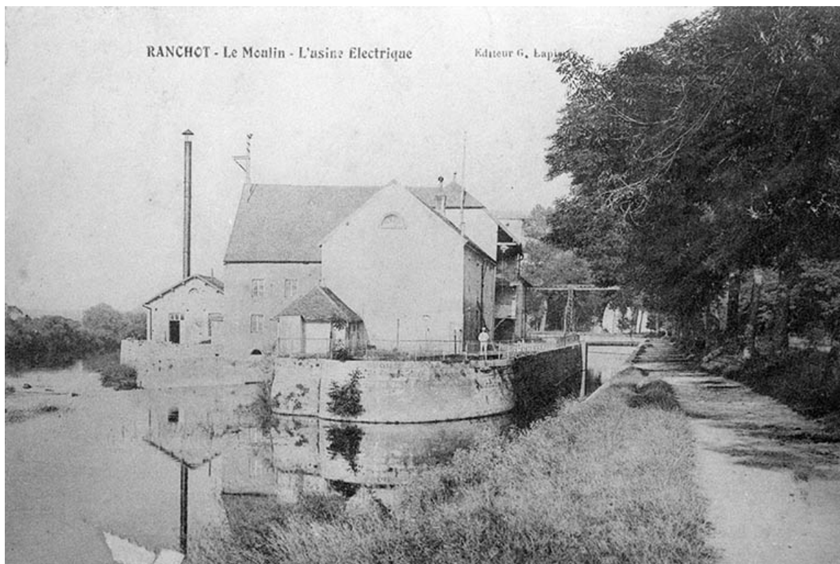
Ranchot. Le Moulin. L'usine électrique.
