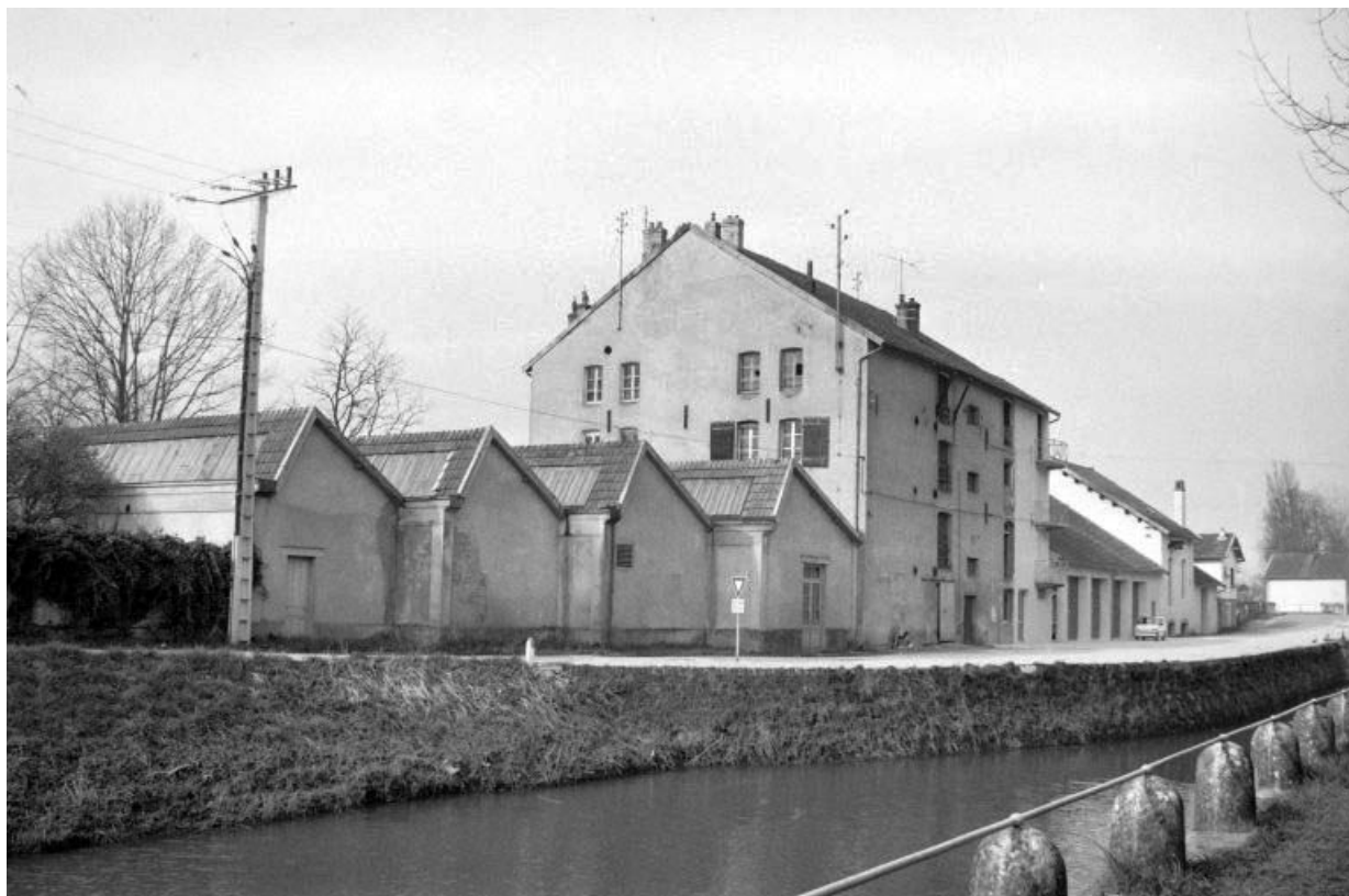
Façade antérieure vue de l'est.
